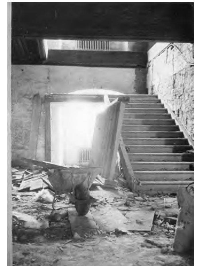
Abriss der Treppe aus den 1820er Jahren, um 1960
