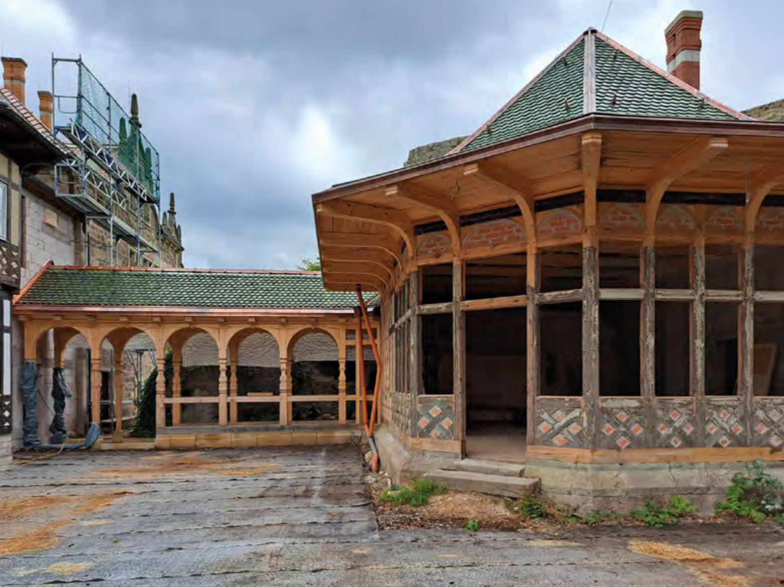
Schloss Altenstein, Küchenbau während der Sanierung mit neuer Ziegeldeckung
