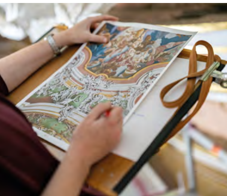
Schadkartierung der Festsaaldecke
