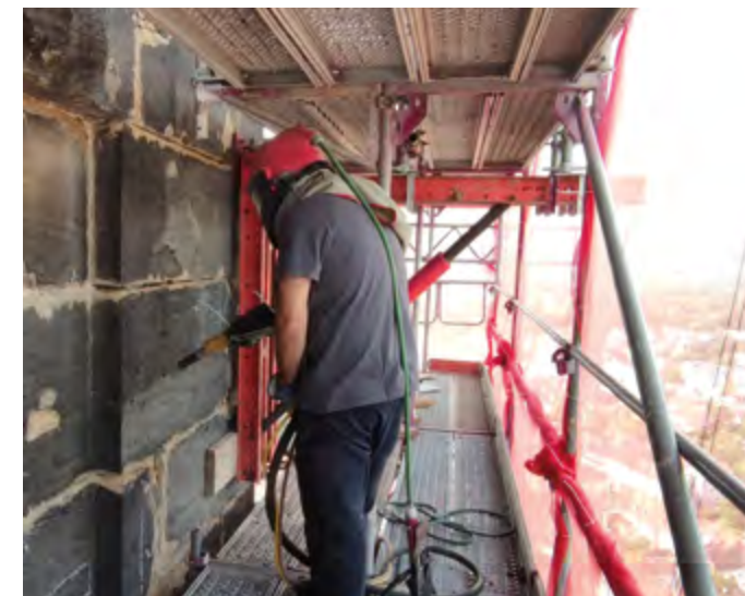
Reinigung des Turmmauerwerks im Sandstrahlverfahren
