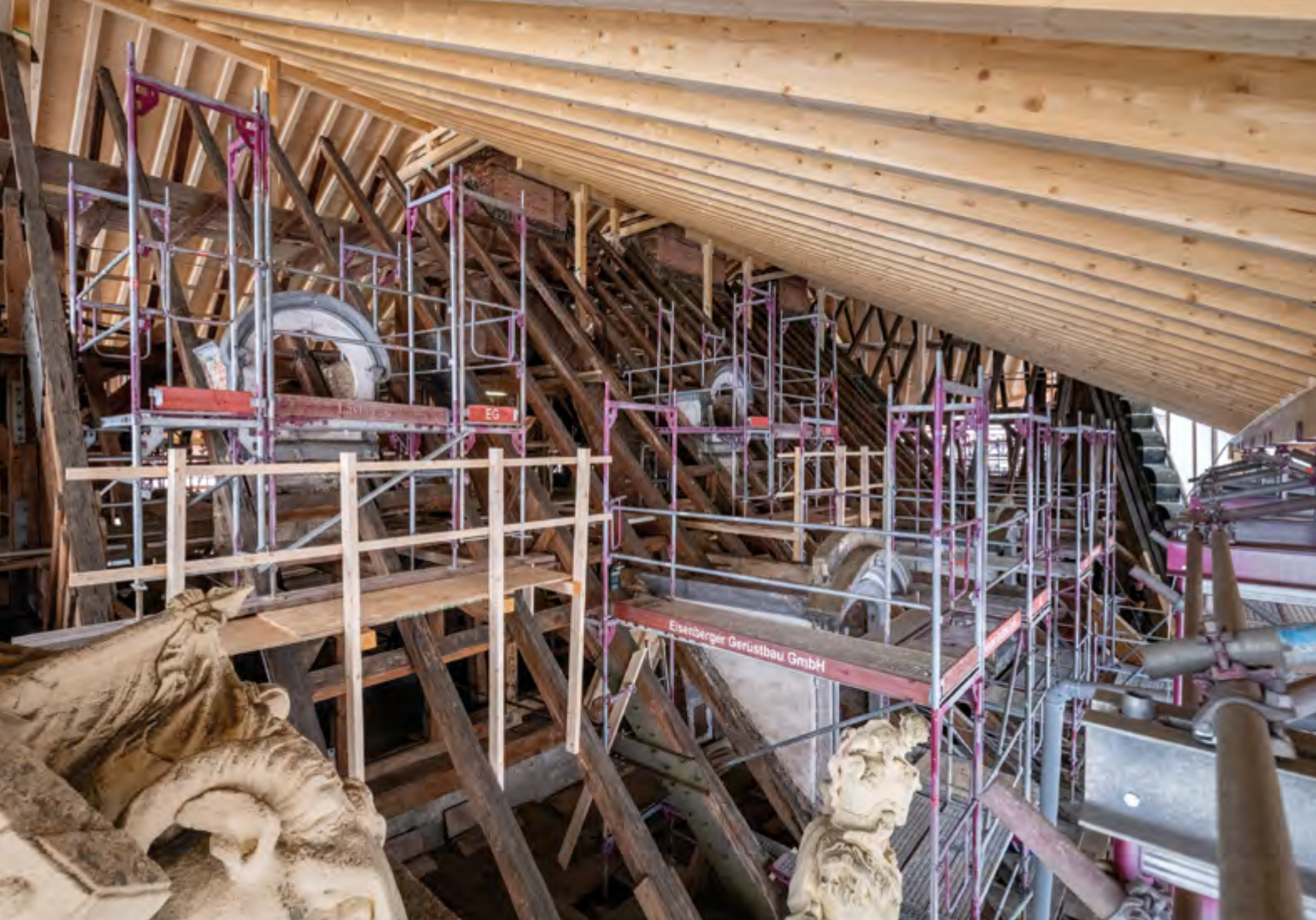
Blick unter das Schutzdach mit freigelegtem Dachstuhl
