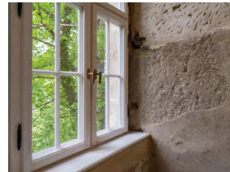
Fensterdetail im sanierten Empfangsbereich
