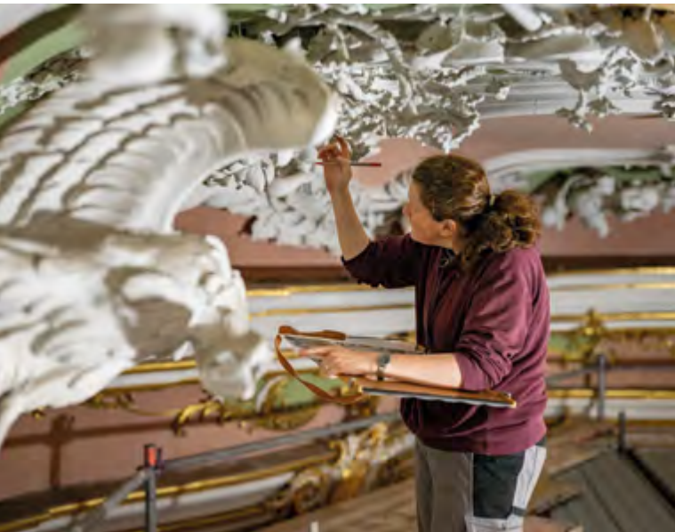
Restauratorische Untersuchungen am Deckenstuck
