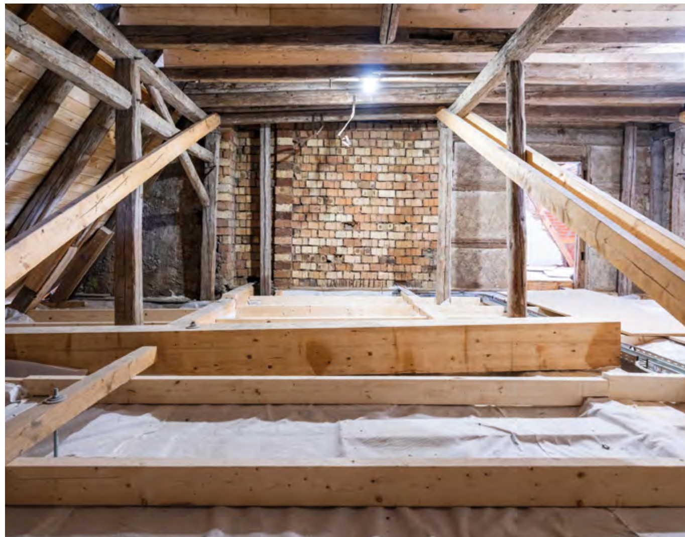
Dornburger Schlösser, Renaissanceschloss, sanierter Dachstuhl über der Bergstube
