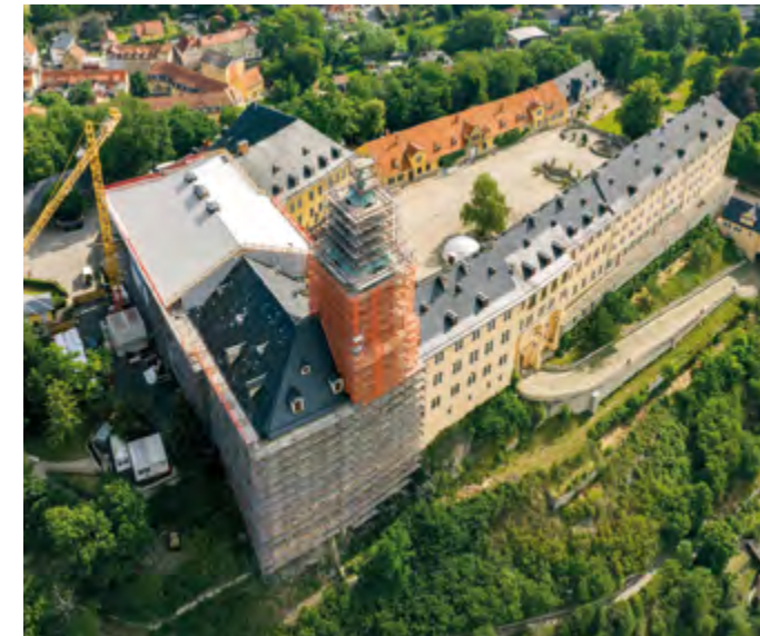
Schloss Heidecksburg mit Baugerüst an Westflügel und Turm
