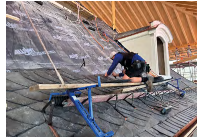
Beginn der Schieferarbeiten
