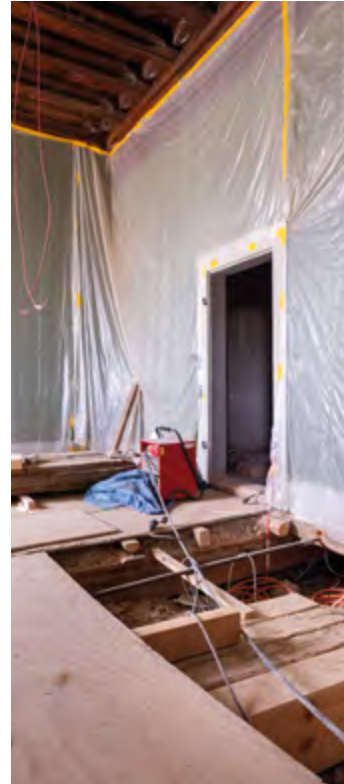
Deckensanierung vor der Bergstube
