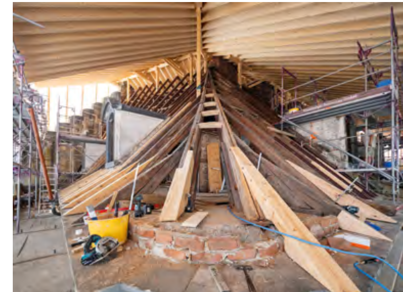
Reparaturstelle an der Dachkonstruktion
