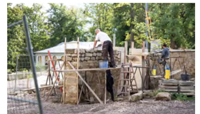
Parkmauersanierung im Umfeld des Pavillons
