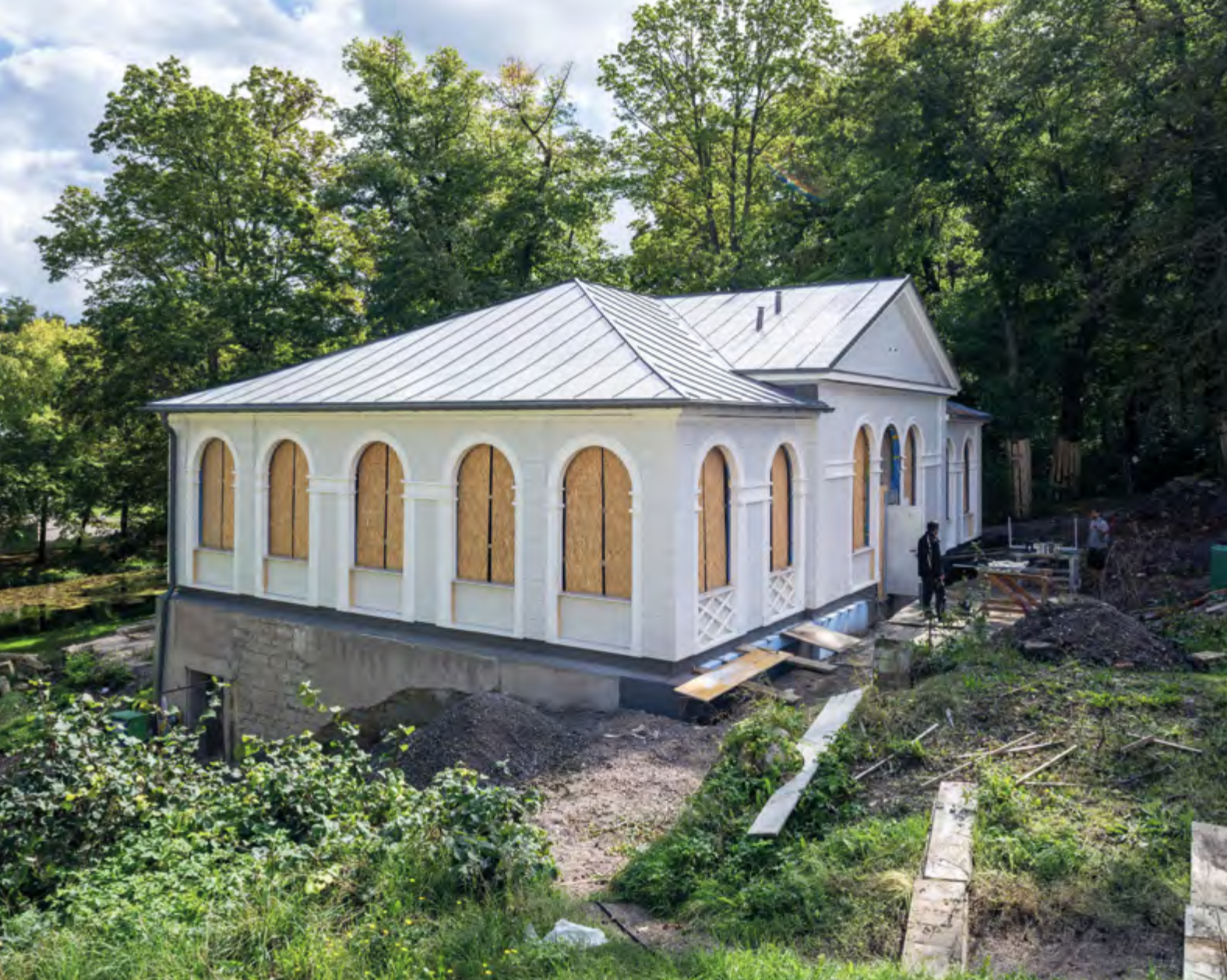
Schlosspark Molsdorf, Pavillon mit saniertem Dach und Fassaden
