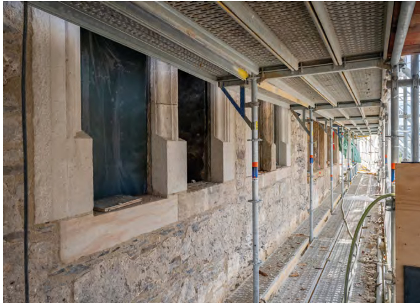
Burg Ranis, wiederhergestellte Fenstergewände am Torhaus
