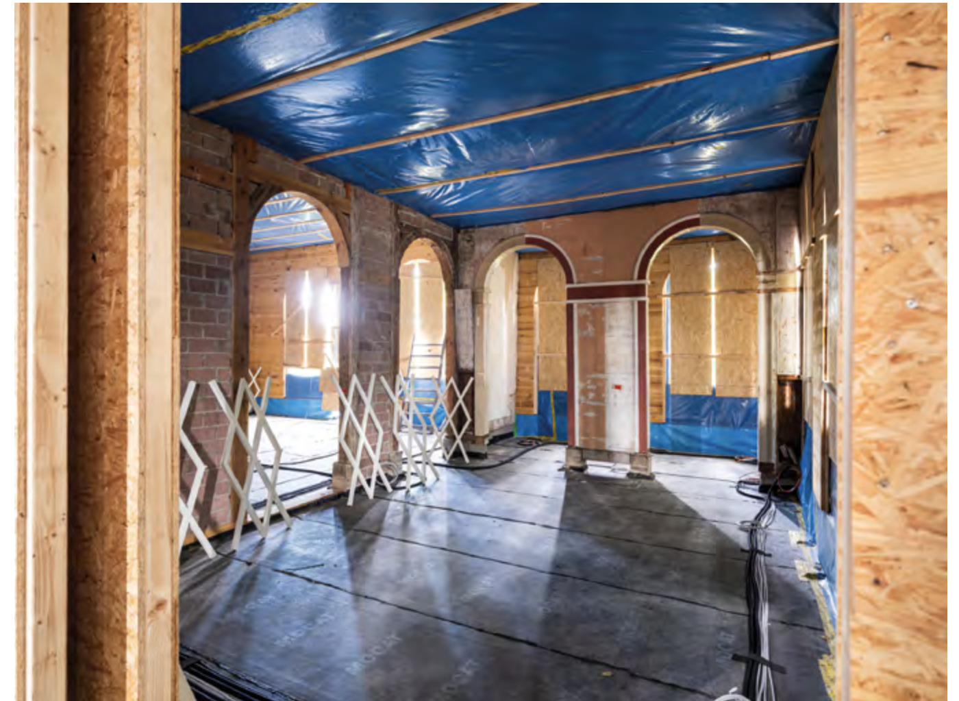
Blick in den Pavillon während des Innenausbaus
