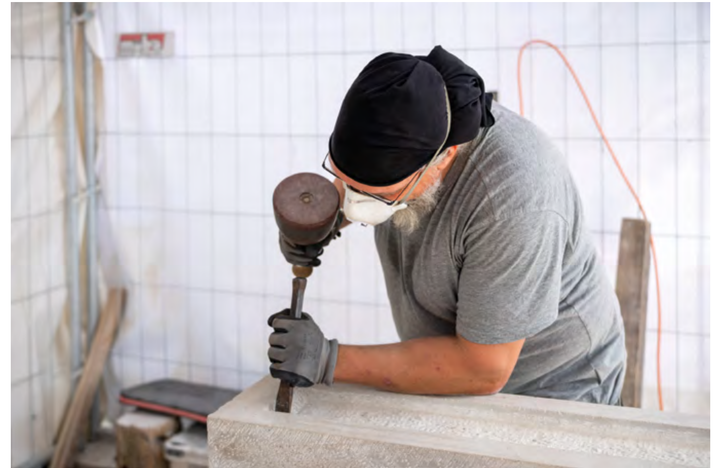
Burg Ranis, Steinmetz beim Herstellen eines Sandstein-Fenstergerüdes
