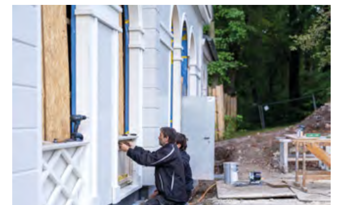
Letzte Arbeiten an den Holzfassaden
