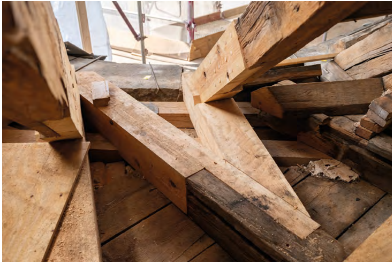
Schloss Heidecksburg Rudolstadt, Zimmermannsarbeiten am Dach
