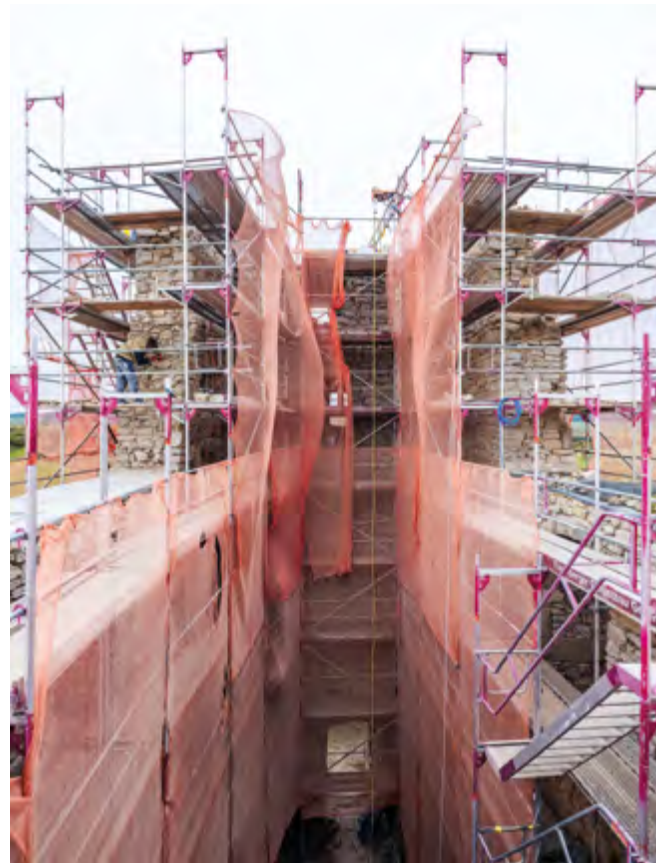
Burgruine Ehrenstein während der Sanierung
