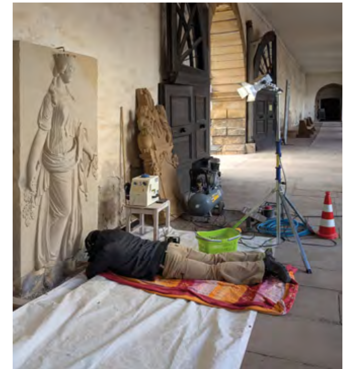
Reinigungsarbeiten an den Reliefs
