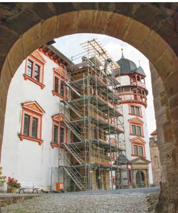
Eingerüstete Herrenerker während der Restaurierung 2026
