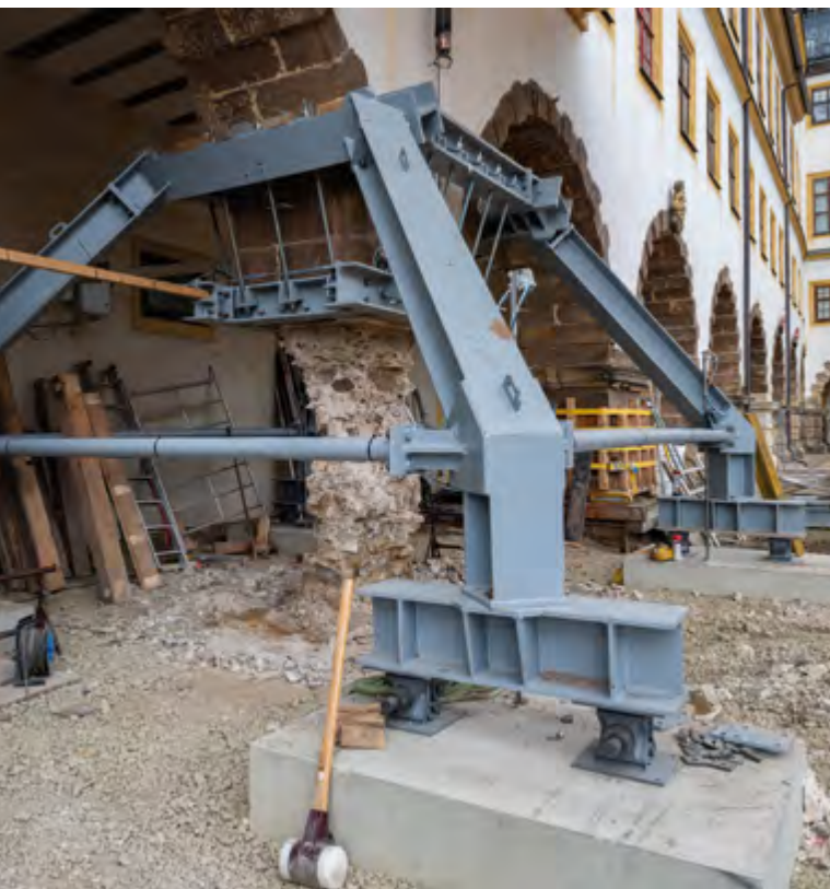
Sanierung der Arkadenpfeiler im Schlosshof
