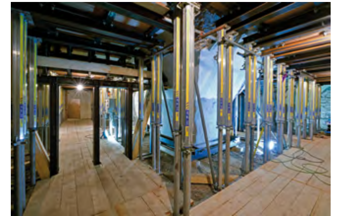
Gotha, Schloss Friedenstein, Stahlkonstruktion zur Notsicherung des Ostturms
