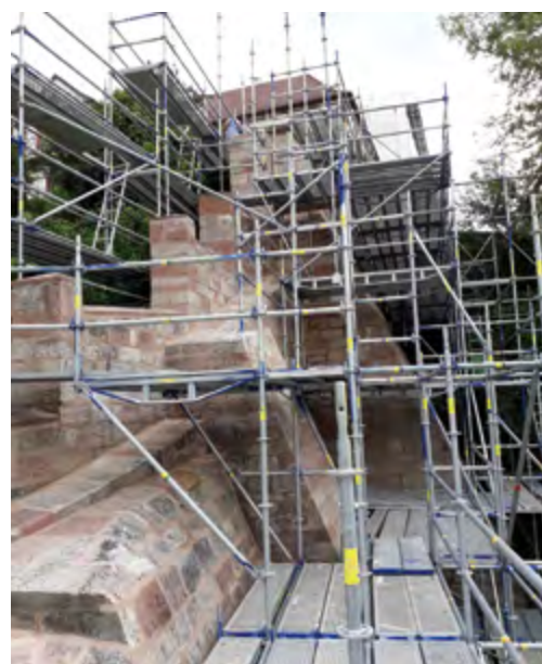
Schmalkalden, Schloss Wilhelmsburg, Sanierung einer Stützmauer
