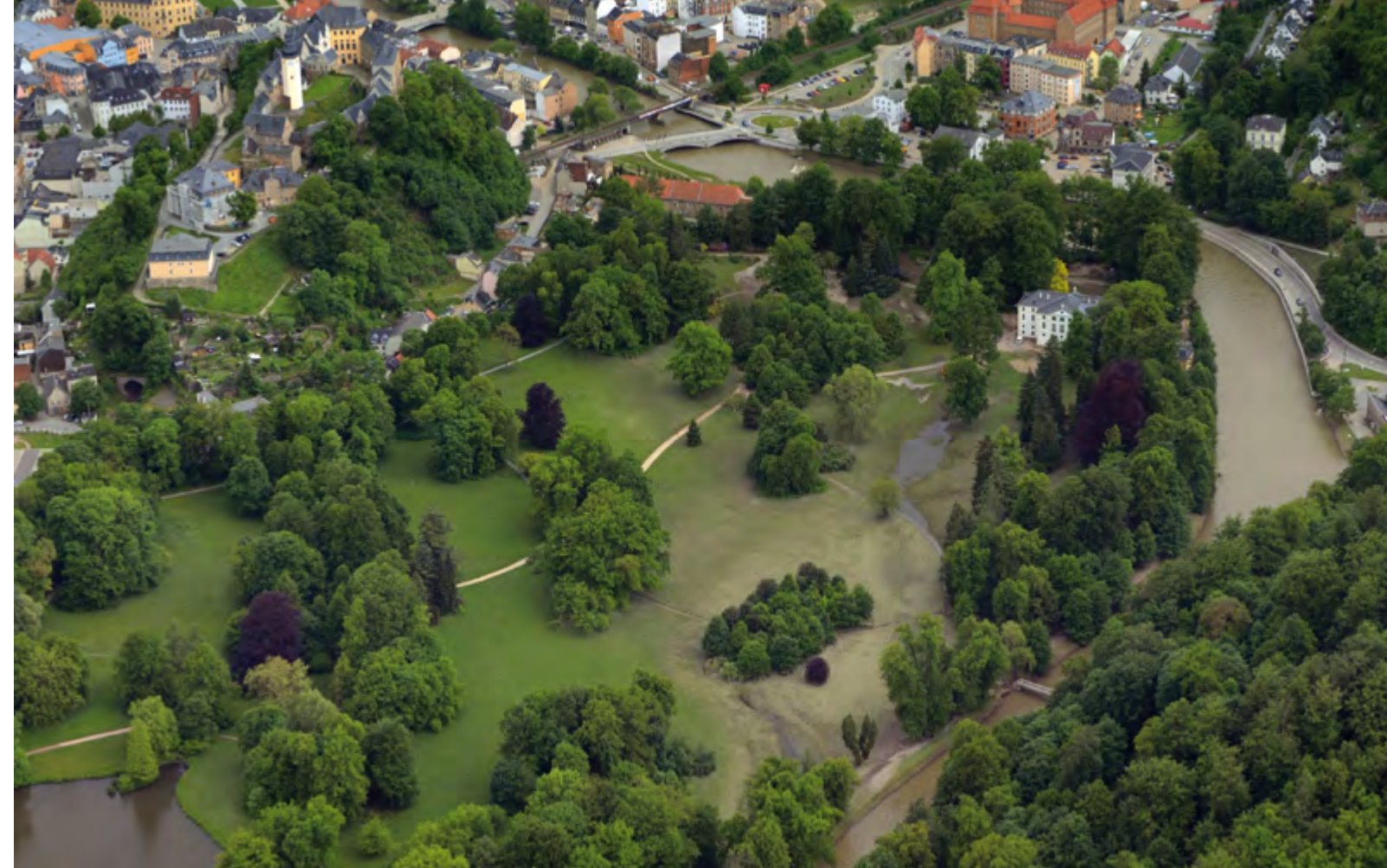
Fürstlich Greizer Park, Hochwasserschäden 2013
