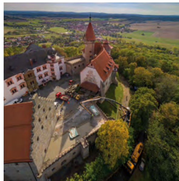
Veste Heldburg, Herstellung der Bodenplatte für den Gastronomieneubau
