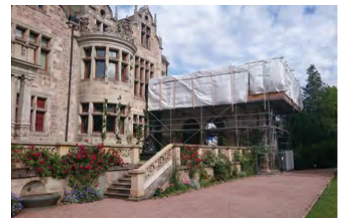
Bad Liebenstein, Schloss Altenstein, Sanierung des Portikus
