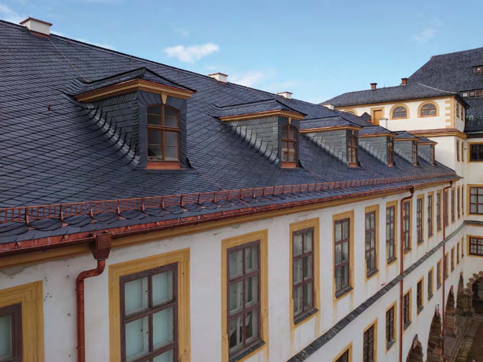
Gotha, Schloss Friedenstein, saniertes Dach am Nordteil des Westflügels
