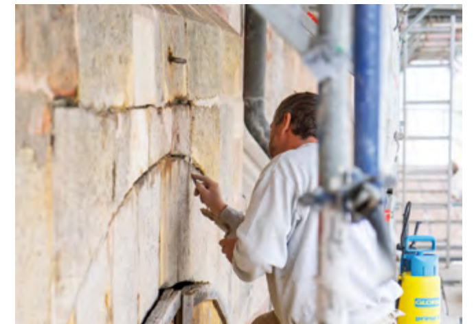
Erfurt, Klosterkirche St. Peter und Paul, Restaurierungsarbeiten an den Fassaden
