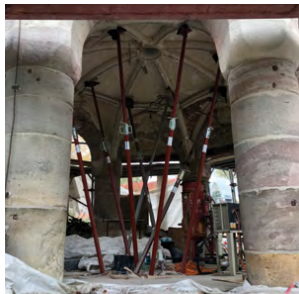
Schleusingen, Schloss Bertholdsburg, Brunnenhaus während der Sanierung
