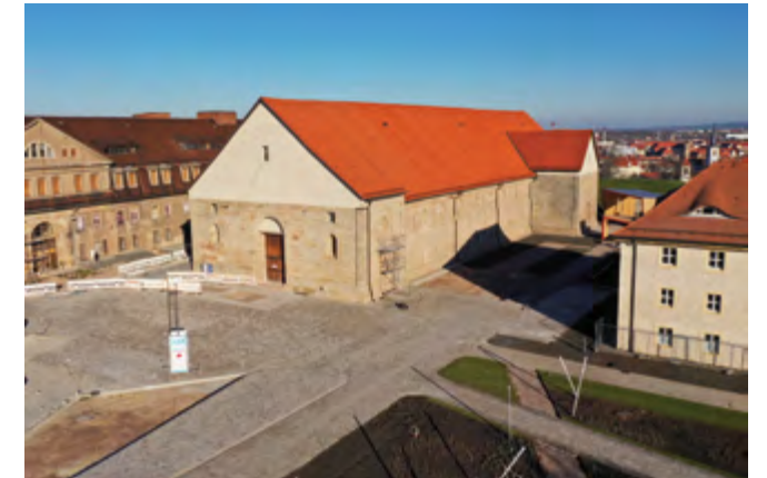
Erfurt, Klosterkirche St. Peter und Paul nach der Restaurierung der Fassaden
