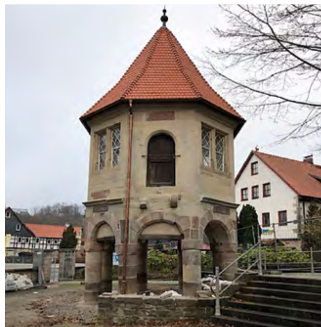
Schloss Bertholdsburg in Schleusingen, Brunnenhaus im Schlossgarten
