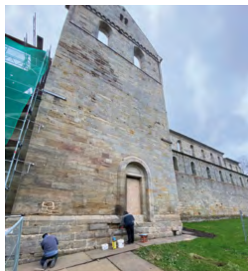
Paulinzella, Klosterkirche, Restaurierungsarbeiten am Mauerwerk der Ruine
