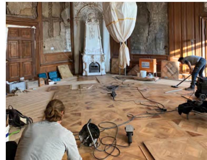
Einbau der restaurierten Parketttafeln
