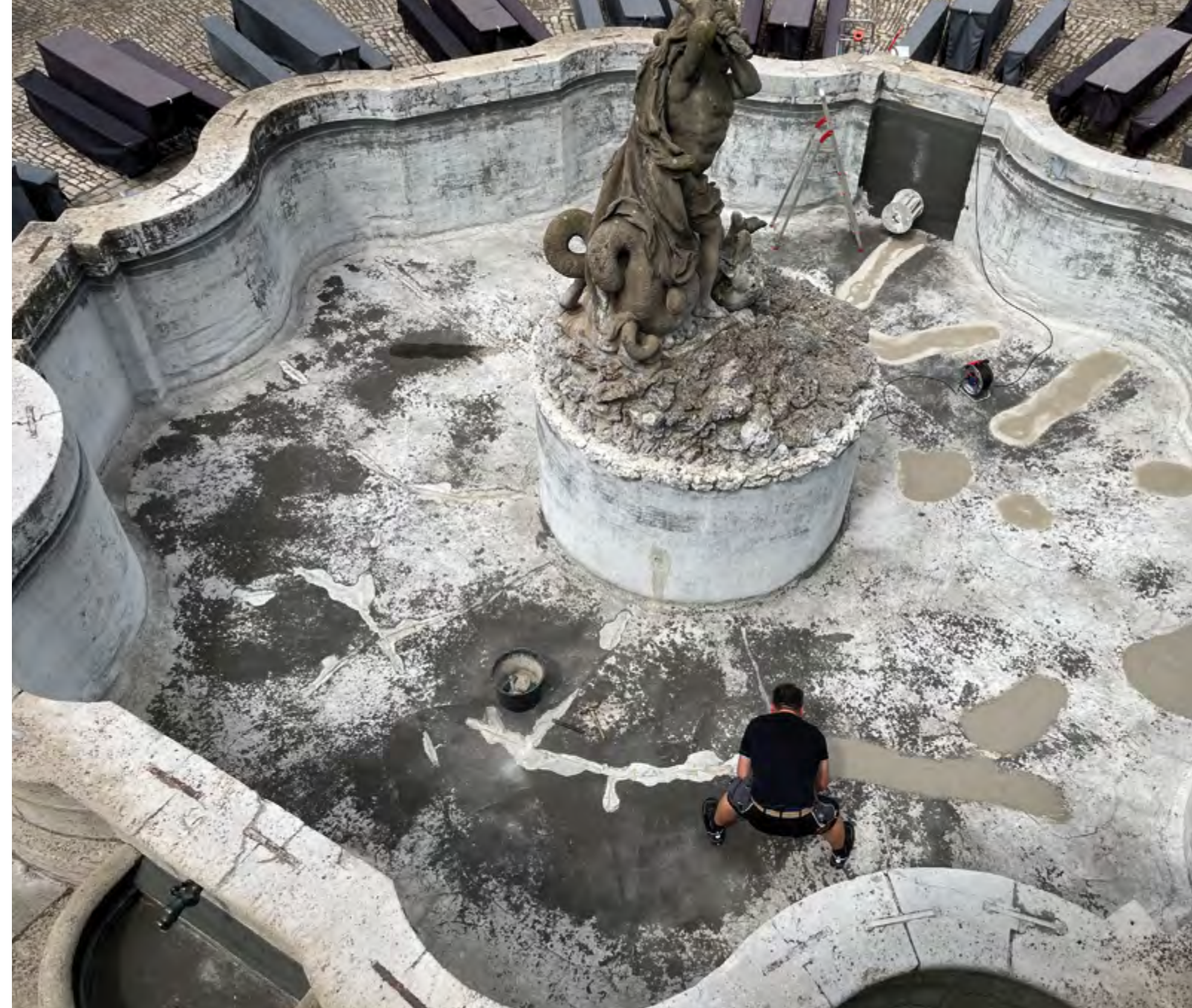
Dichtungsarbeiten am Herkulesbrunnen im Schlosshof Sondershausen
