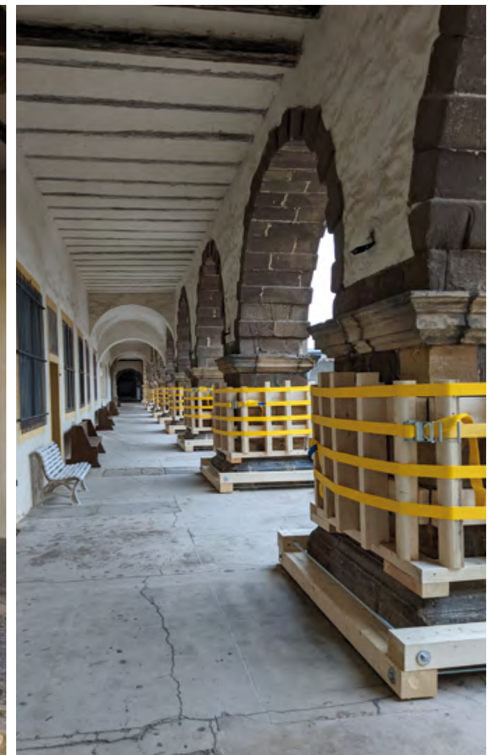
Arkadengang mit gesicherten Pfeilern
