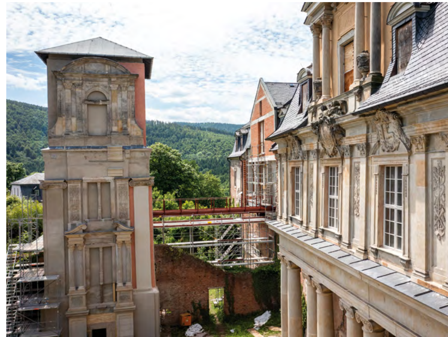
Schlosskirchturm während des Einbaus einer Stahlbrücke zum Hauptgebäude 2021 für die zukünftige Nutzung als zweiter Rettungsweg
