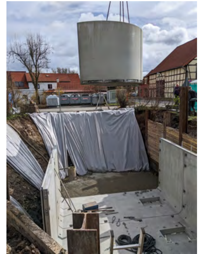
Bau der Löschwasserezisterne für Schloss Molsdorf
