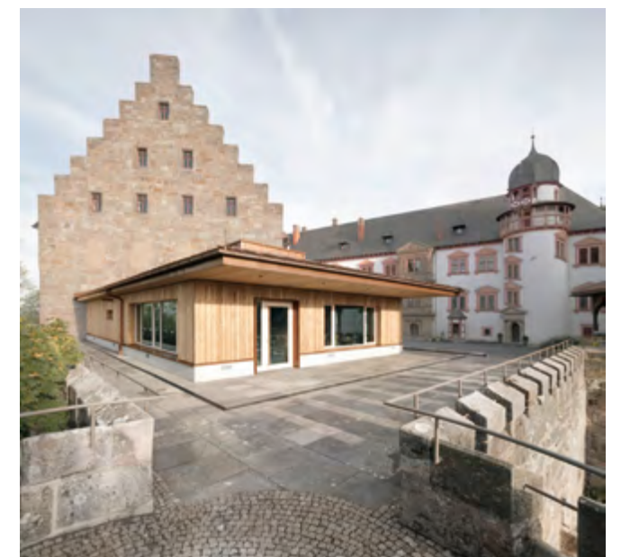
Neuer Gastronomiebau auf der Veste Heldburg
