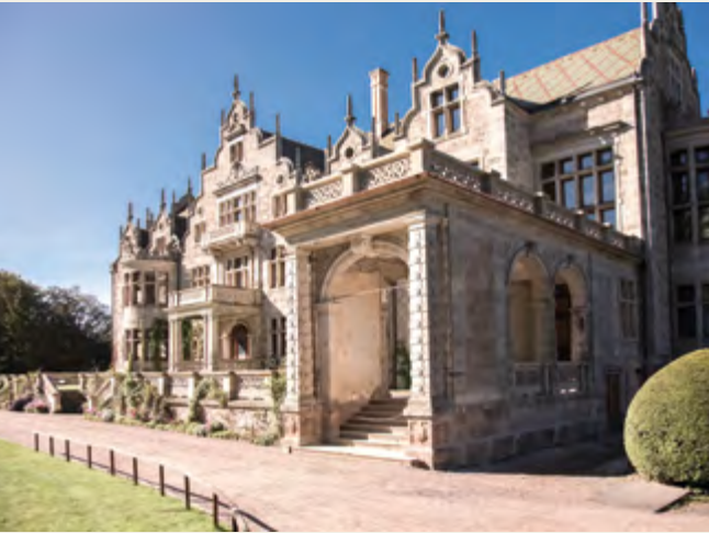
Im Sonderinvestitionsprogramm I der Stiftung Thüringer Schlösser und Gärten sind 23 Einzelprojekte vorgesehen. Jetzt laufen die ersten Bauarbeiten an ... S. 10
