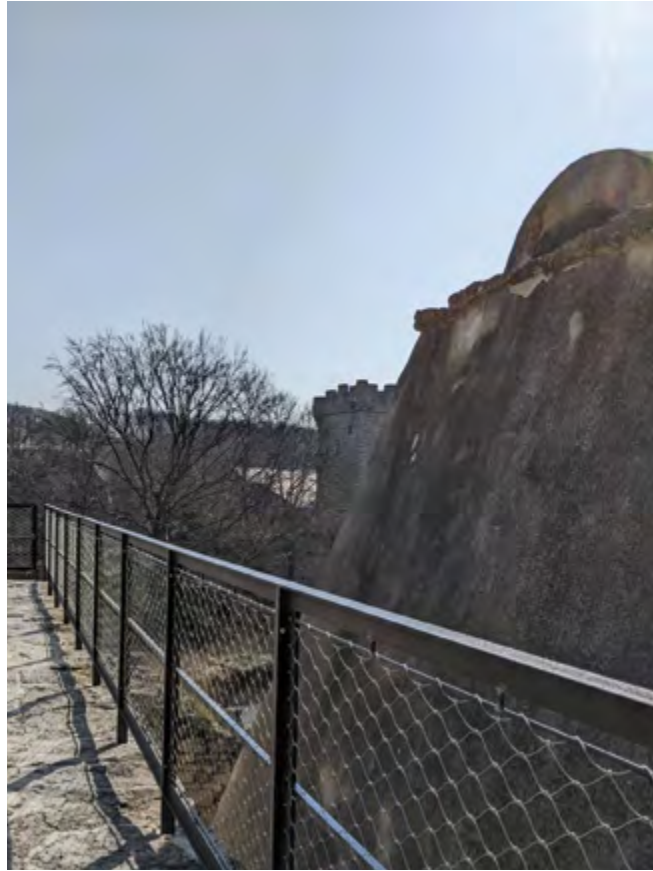
Neues Geländer auf der Wasserburg Kapellendorf
