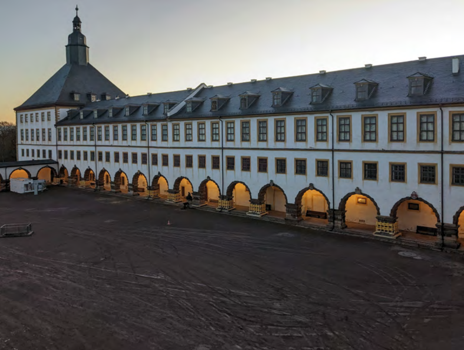
Westflügel von Schloss Friedenstein mit temporären Stützkonstruktionen
