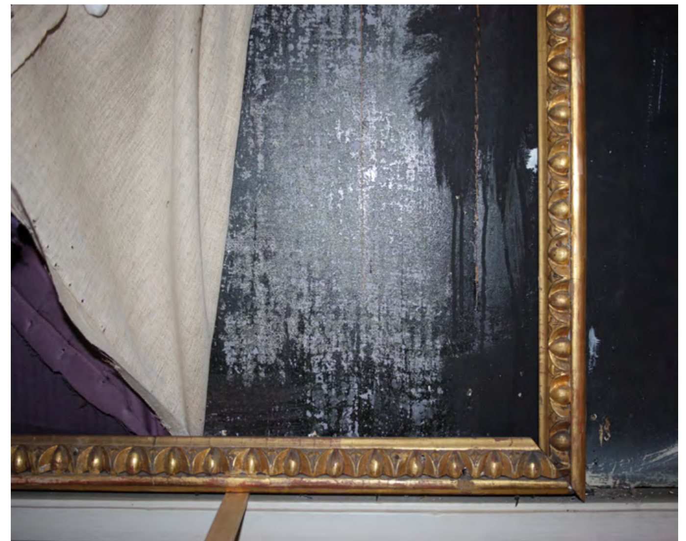
Ursprüngliche Lackierung der Wandflächen unter der heutigen Bespannung
