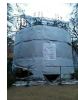
Eingerüstete Rotunde im Fürstlich Greizer Park
