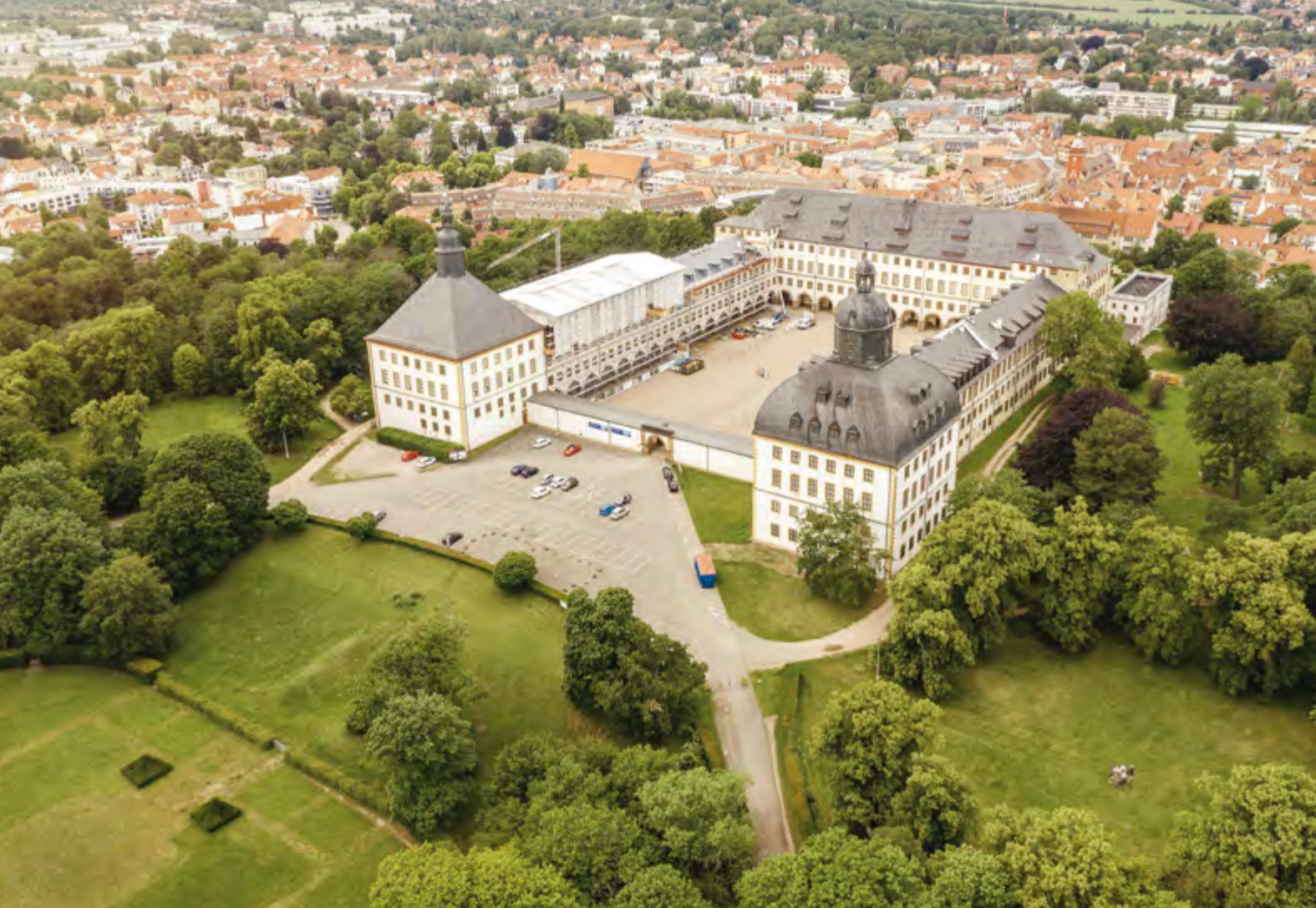
Schloss Friedenstein in Gotha während der Dachsanierung
