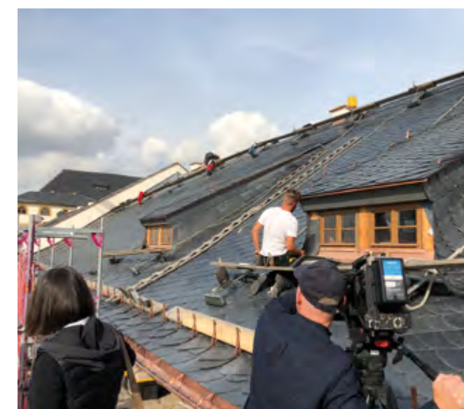
Letzte Arbeiten am Dach des Westflügels von Schloss Friedenstein
