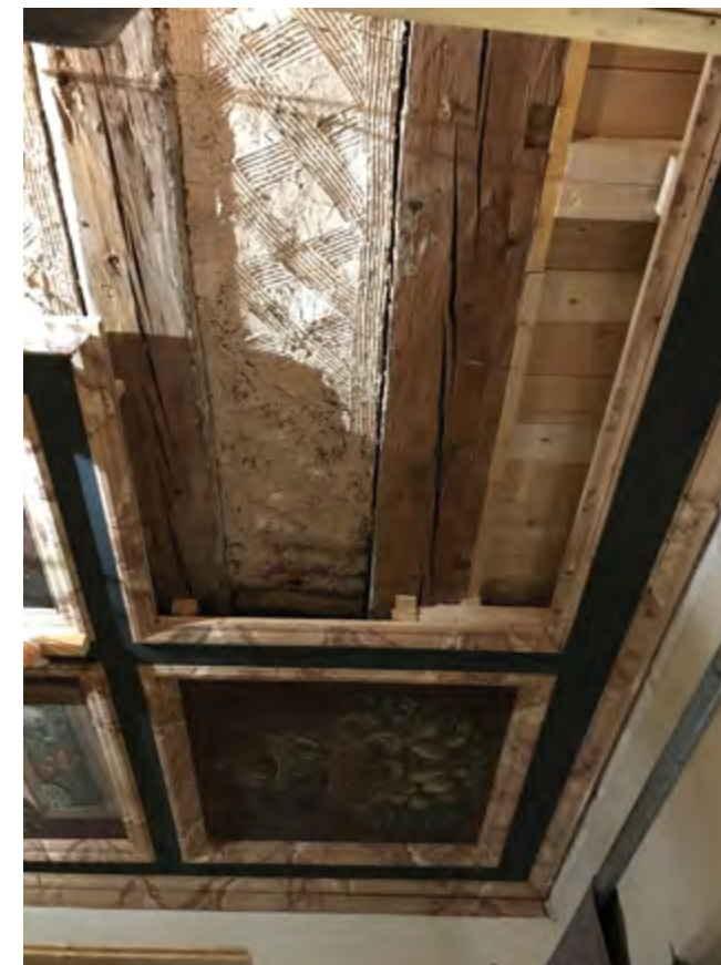
Restaurierungsarbeiten im Gemach des Landgrafen
