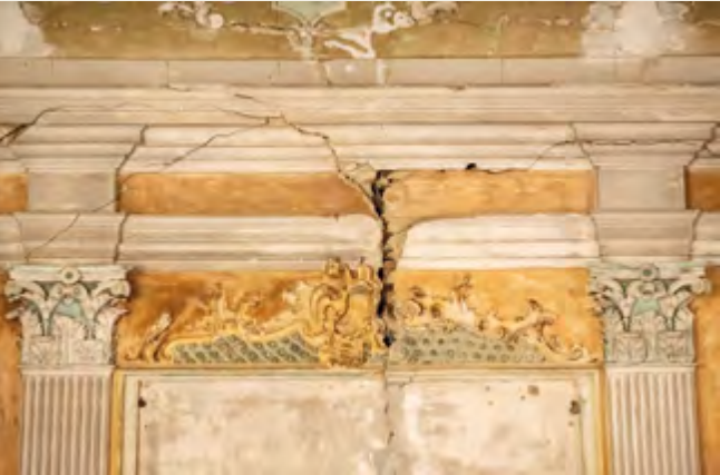
70 Jahre Ruine, zehn Jahre Baustelle – nach 80 Jahren sind erste Räume im Hauptgebäude von Schloss Schwarzburg wieder nutzbar. Die Spuren der Geschichte sind deutlich sichtbar und bilden den Rahmen für den Denkort der Demokratie. S. 10
