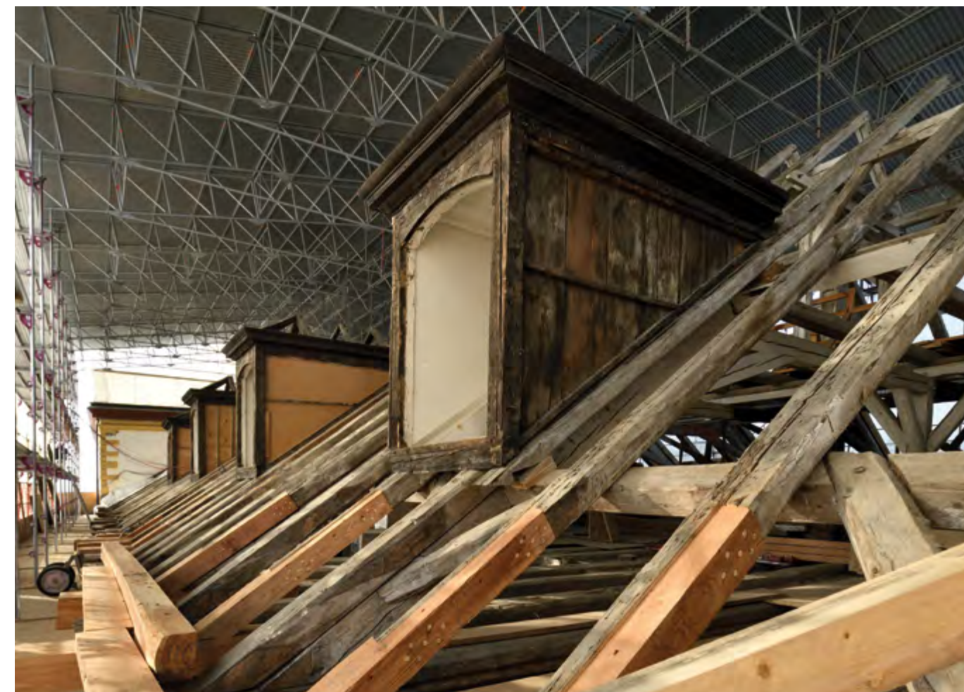
Sanierung von Dachsparren
