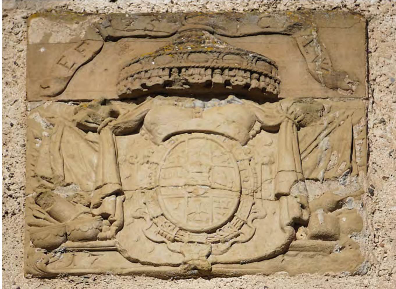
Wappenstein an der Südfassade über dem Burgtor
