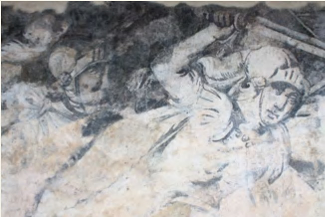
Monumentale Malereien an Außenwänden aus der Frühen Neuzeit sind eine Rarität. Am Reithaus in Rudolstadt haben sich Fragmente davon erhalten ... S. 26
