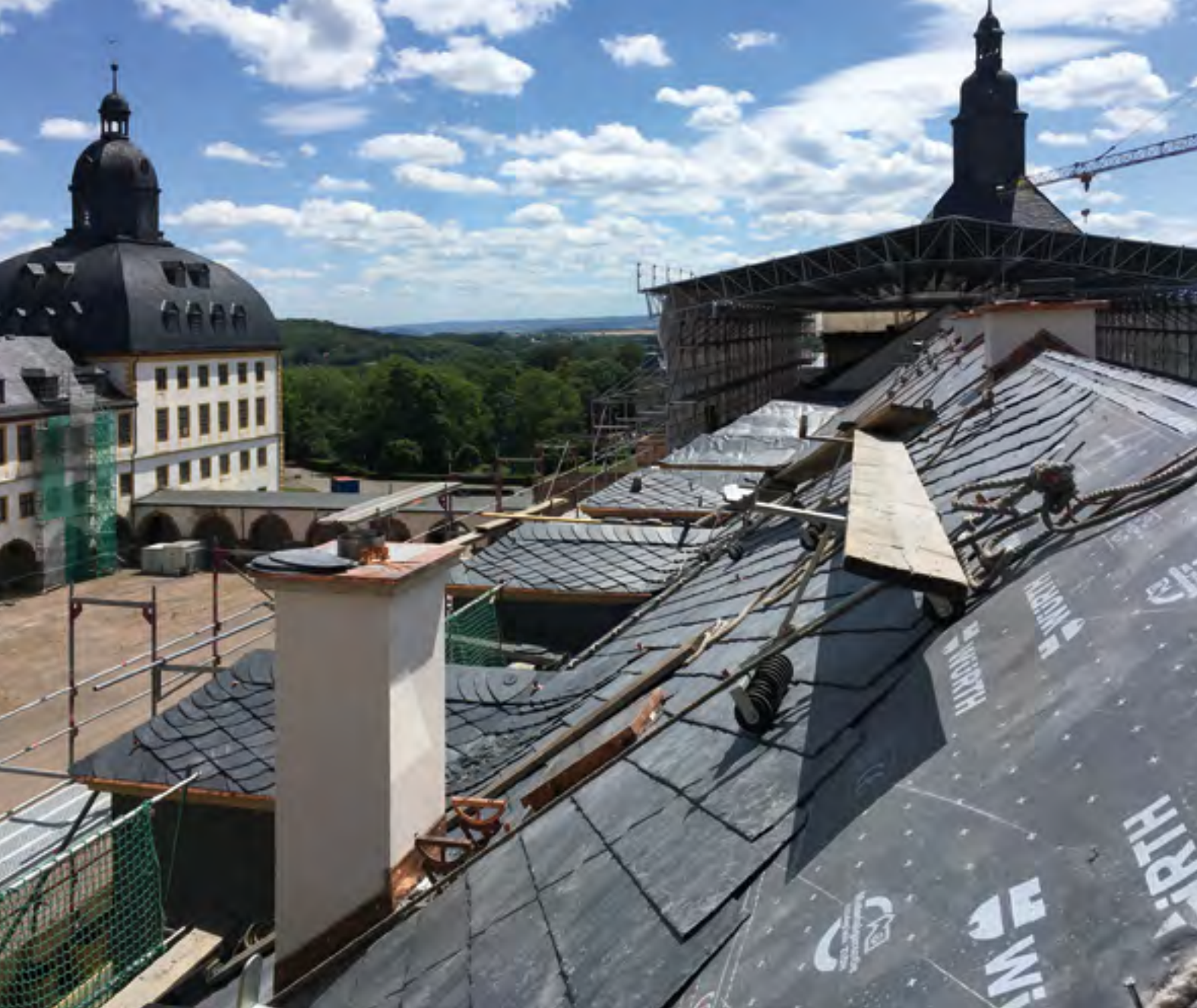
Gotha, Schloss Friedenstein, Dachdeckerarbeiten auf dem Westflügel
