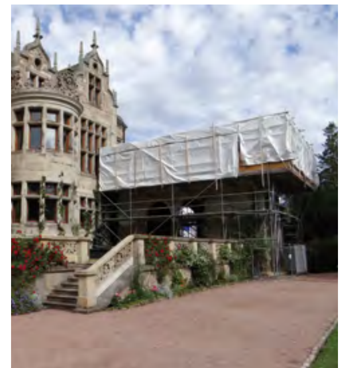
Portikus während der Restaurierung 2020
