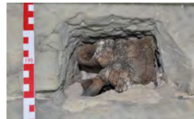
Rest eines Rüstholzes im Mauerwerk
