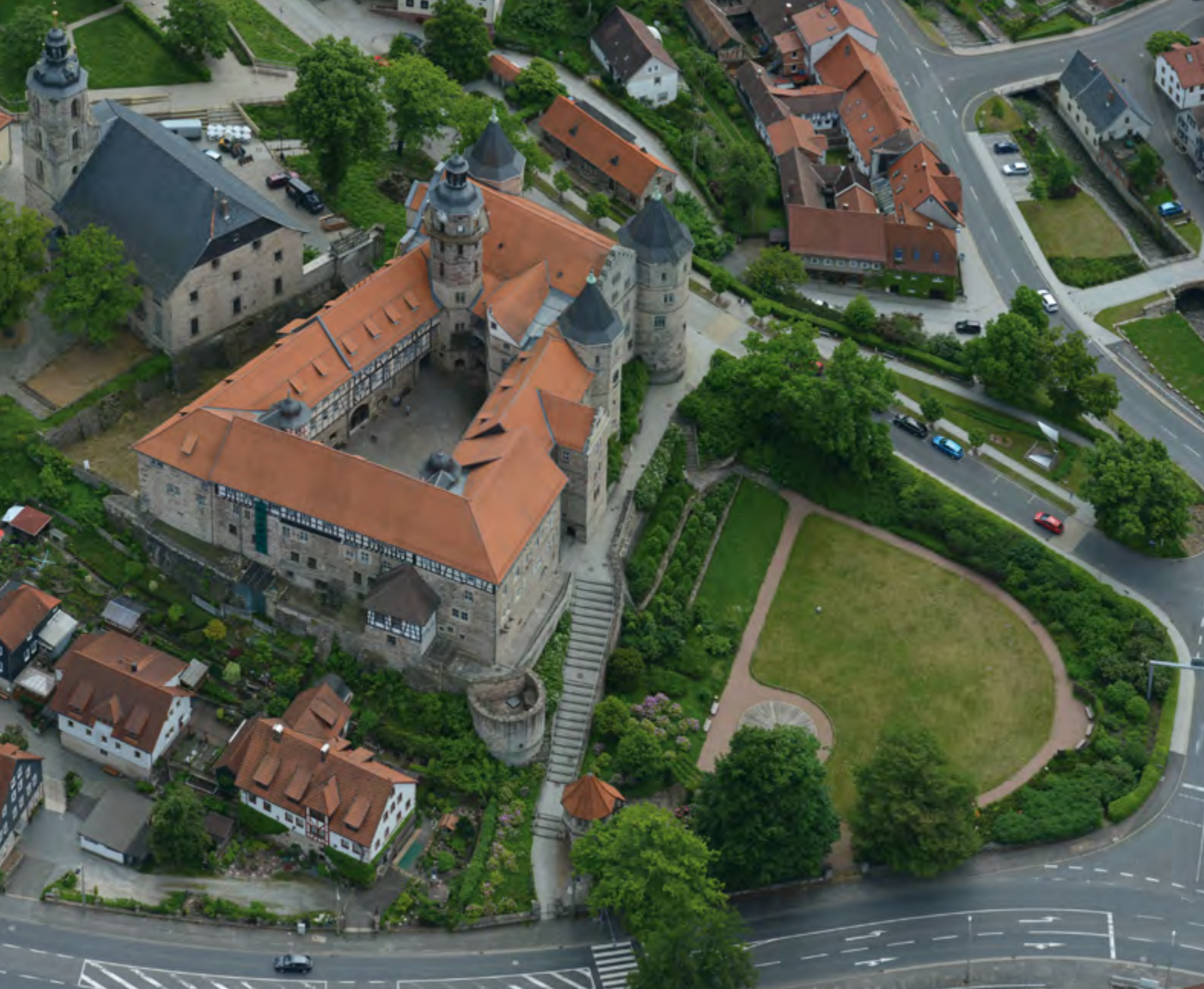
Schleusingen, Schloss Bertholdsburg aus der Luft mit Brunnenhaus am unteren Ende der Freitreppe
