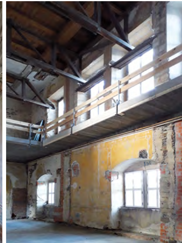
Sogenannter Emporensaal mit eingebauter Empore
