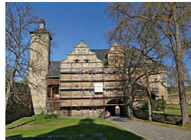
Burg Ranis, Notsicherung des Giebels an der Vorburg
