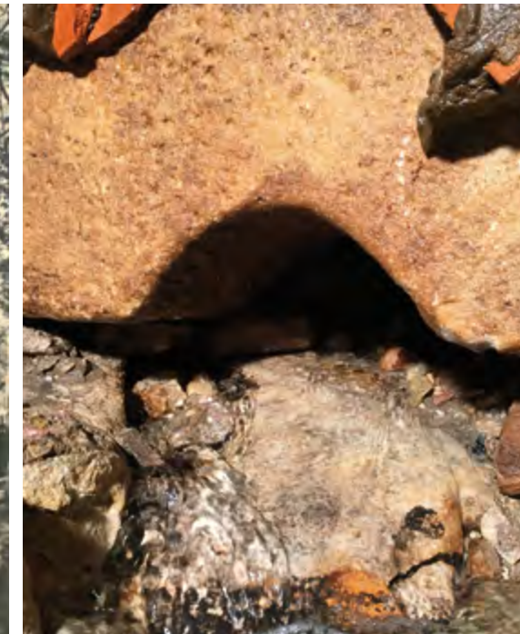
Quellöffnung in der Brunnenstube
