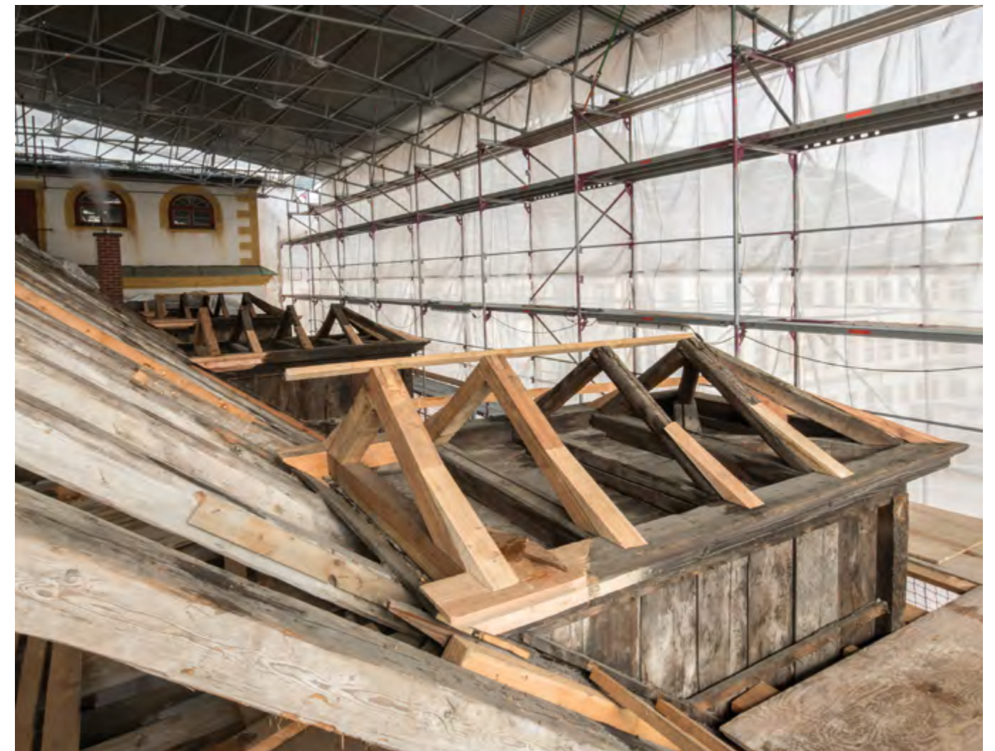
Gotha, Schloss Friedenstein, Dachsanierung am Westflügel
