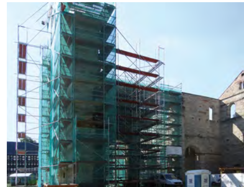
Kloster Paulinzella, Restaurierungsarbeiten
