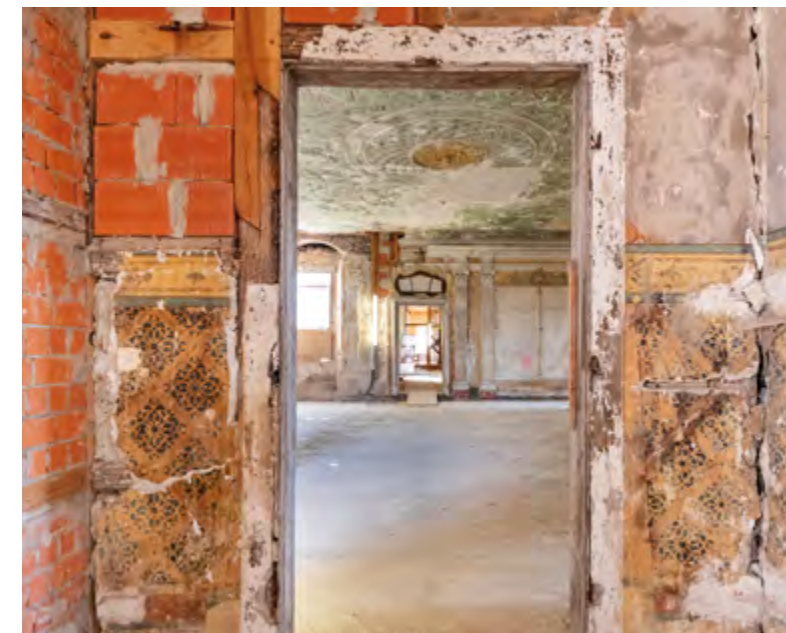
Schloss Schwarzburg, Schaubaustelle
