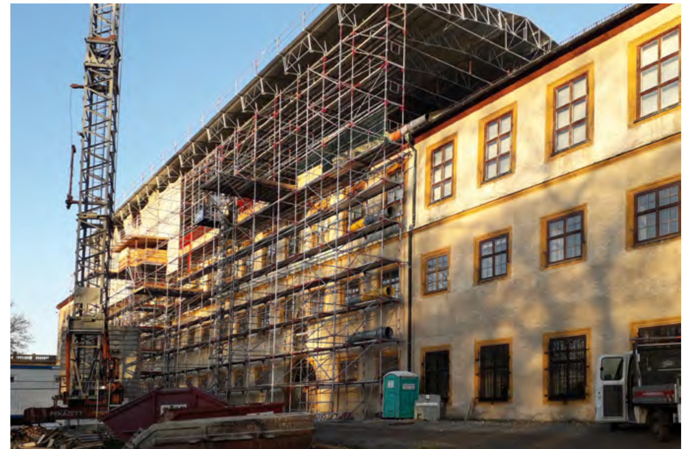
Gotha, Schloss Friedenstein, Dachsanierung
