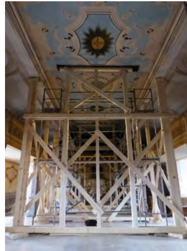
Schloss Sondershausen, Schlosskirche mit Stützkonstruktion
