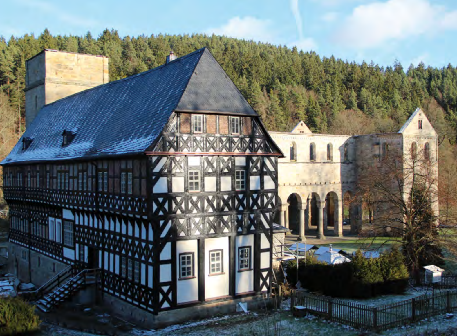
Klosterensemble Paulinzella, Amtshaus nach der Sanierung
