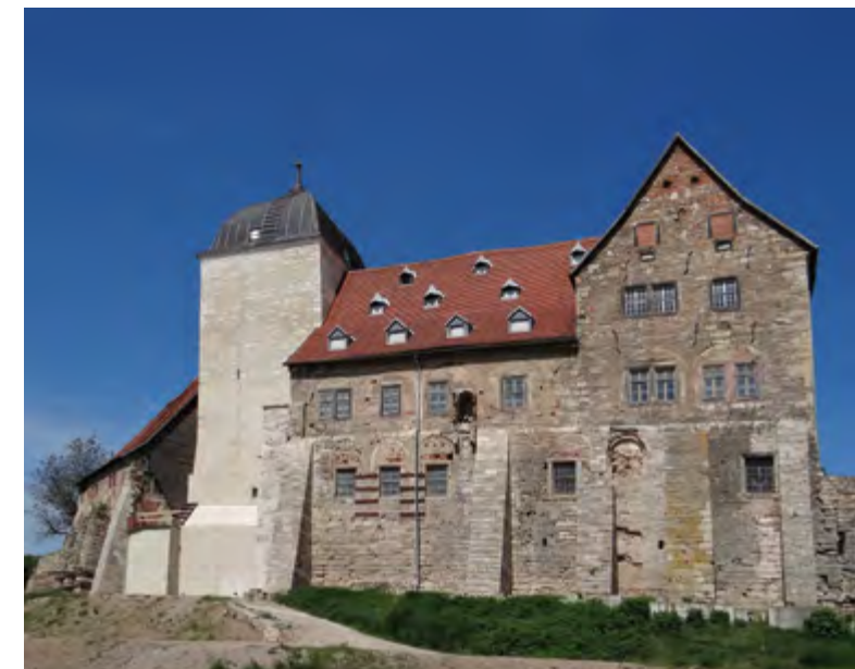
Burg Weißensee, sanierter Turm und unsanierter Palas
