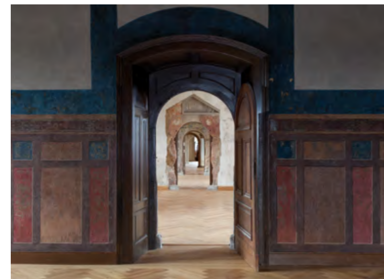
Veste Heldburg, saniertes Hauptgeschoss im Französischen Bau
