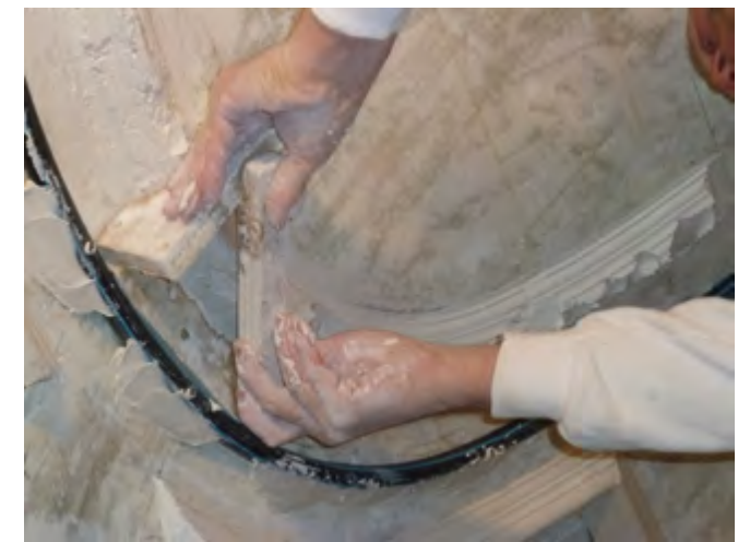
Gotha, Schloss Friedenstein, Ziehen von Stuck im Herzoglichen Treppenhaus
