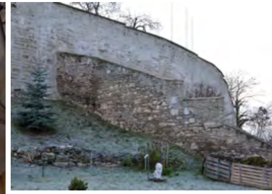
Burg Weißensee/Runneburg, sanierter Abschnitt der Ringmauer
