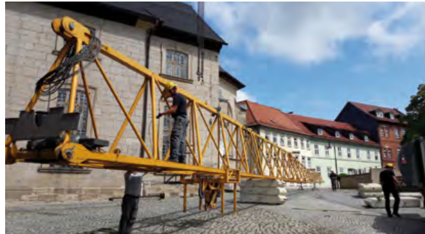
Schleusingen, Schloss Bertholdsburg, Kran zur Sanierung der Stützmauern
