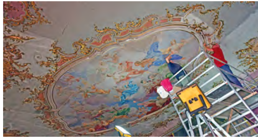
Rudolstadt, Schloss Heidecksburg, Restaurierungsarbeiten im Roten Saal
