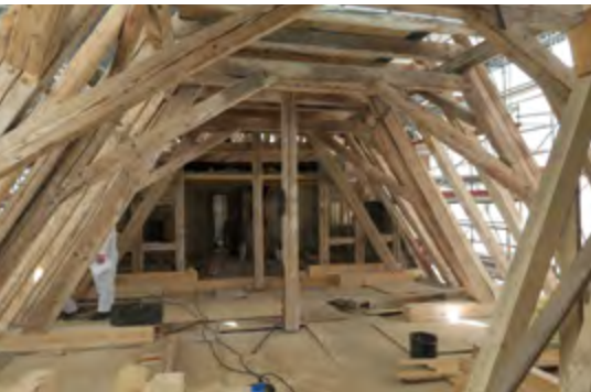
Schmalkalden, Schloss Wilhelmsburg, Dachsanierung am Westflügel
