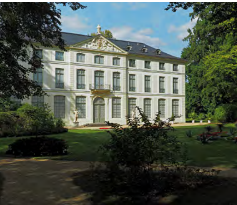
Sommerpalais Greiz vor und nach der 2011 abgeschlossenen Sanierung
