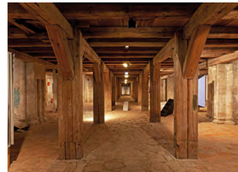
Innenraum der ehemaligen Klosterkirche mit Holzkonstruktion des 19. Jahrhunderts (Erdgeschoss)
