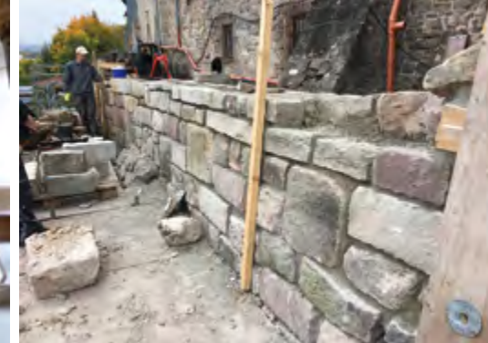
Schleusingen, Schloss Bertholdsburg, Stützmauer während der Sanierung
