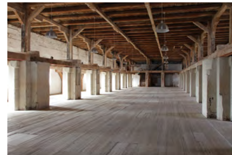
Innenraum der ehemaligen Klosterkirche mit eingezogenem Boden im ersten Obergeschoss
