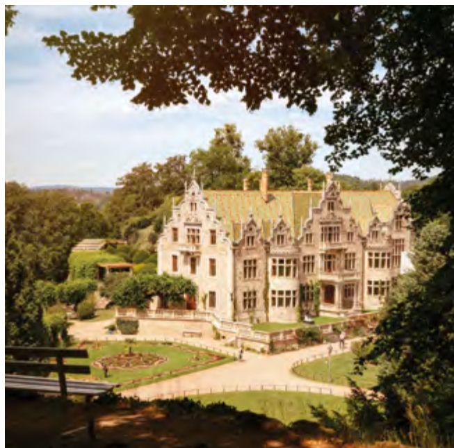
Schloss Altenstein – die Gesamtsanierung soll abgeschlossen werden
