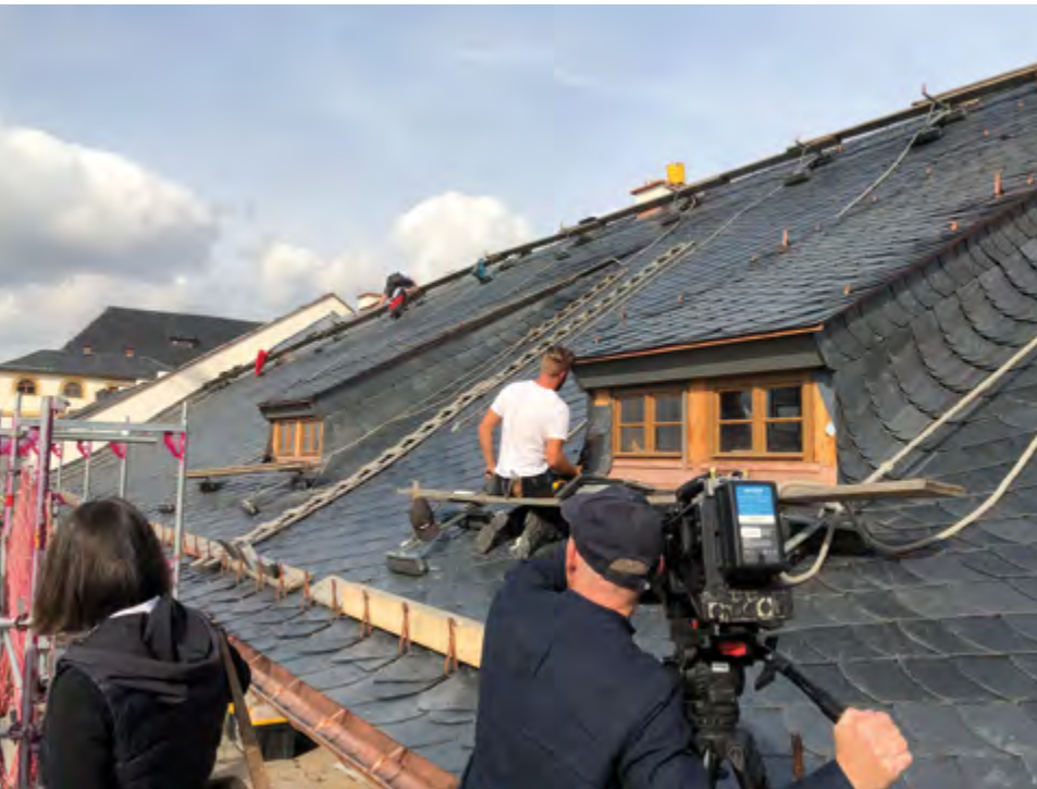
Schloss Friedenstein Gotha, fertiggestelltes Dach am Westturm
