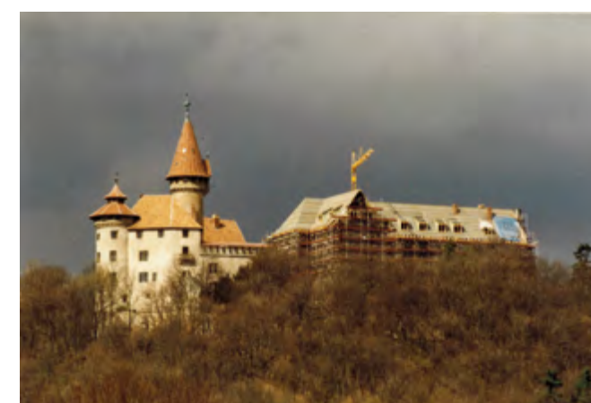
Veste Heldburg während der Wiederaufbauarbeiten am Französischen Bau 1990
