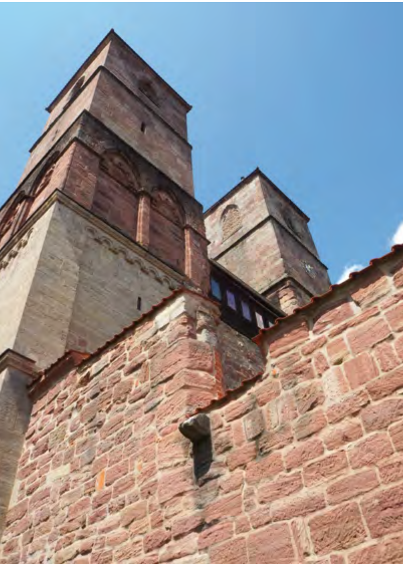
Kloster Veßra, Mauerkronensanierung an der Klosterkirche
