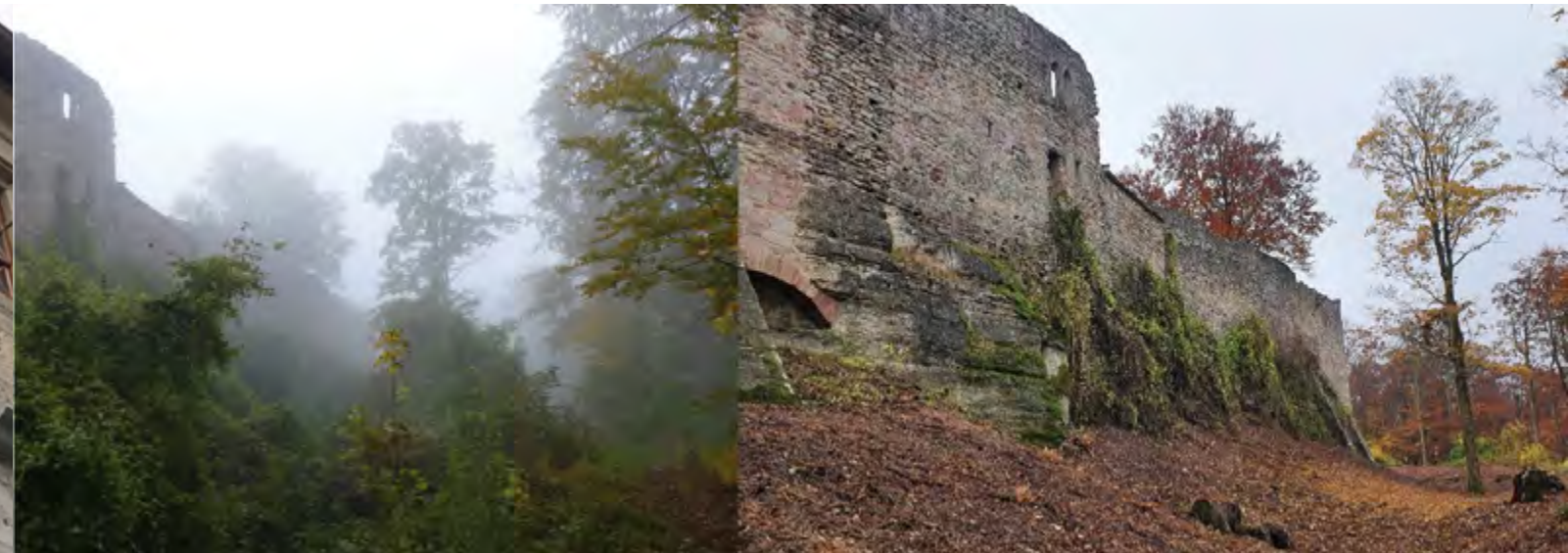
Burgruine Henneberg, Baumschnitt und Freistellung im Burgraben der Burg
