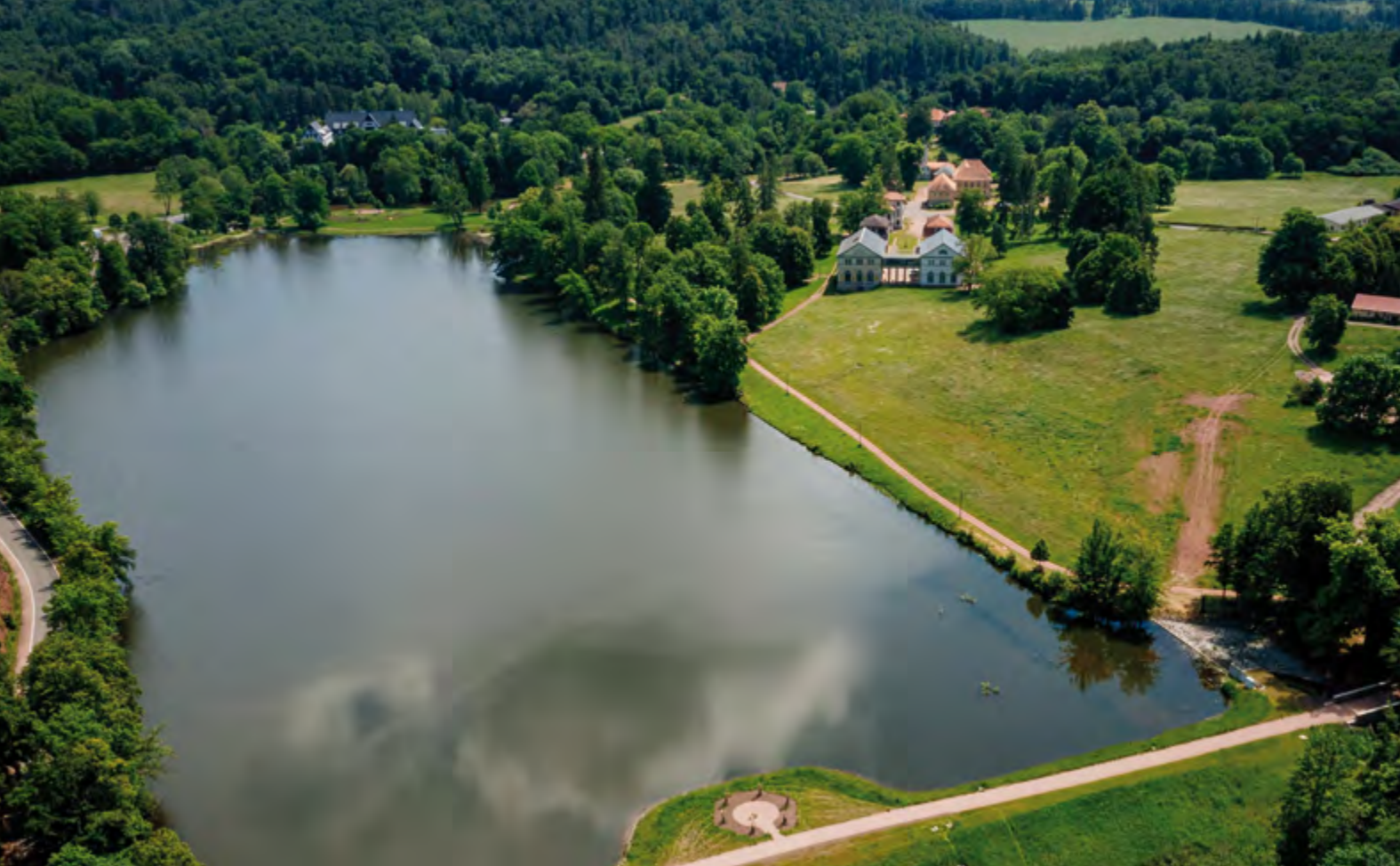
Schlosspark Wilhelmsthal, Parksee mit saniertem Damm
