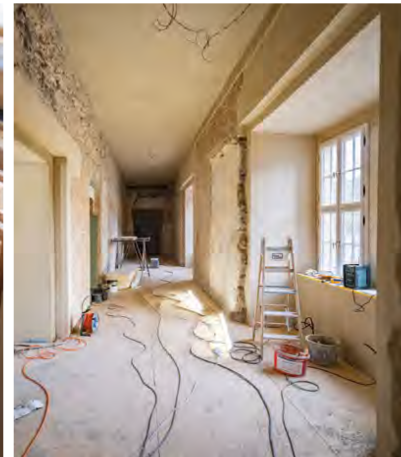
Flurbereich mit Spuren der Entkernungs- und Umbauarbeiten der 1940er Jahre an den Wänden
