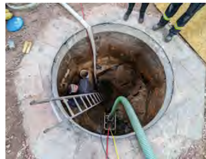
Instandsetzung der Brunnenstube im Garten von Schloss Bertholdsburg
