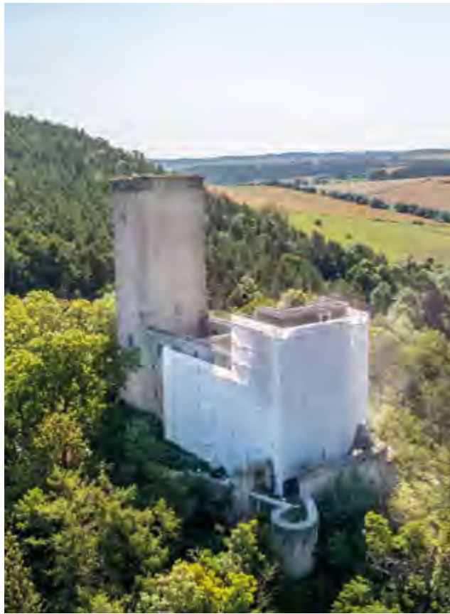
Burgruine Ehrenstein mit Baugerüst
