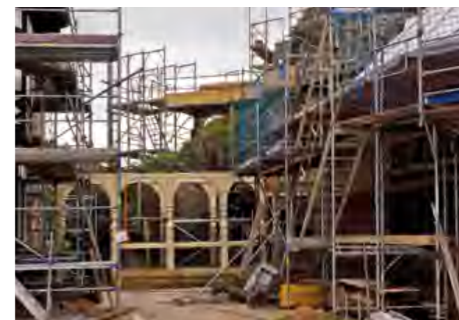
Küchenbau und Laubengang während der Sanierung
