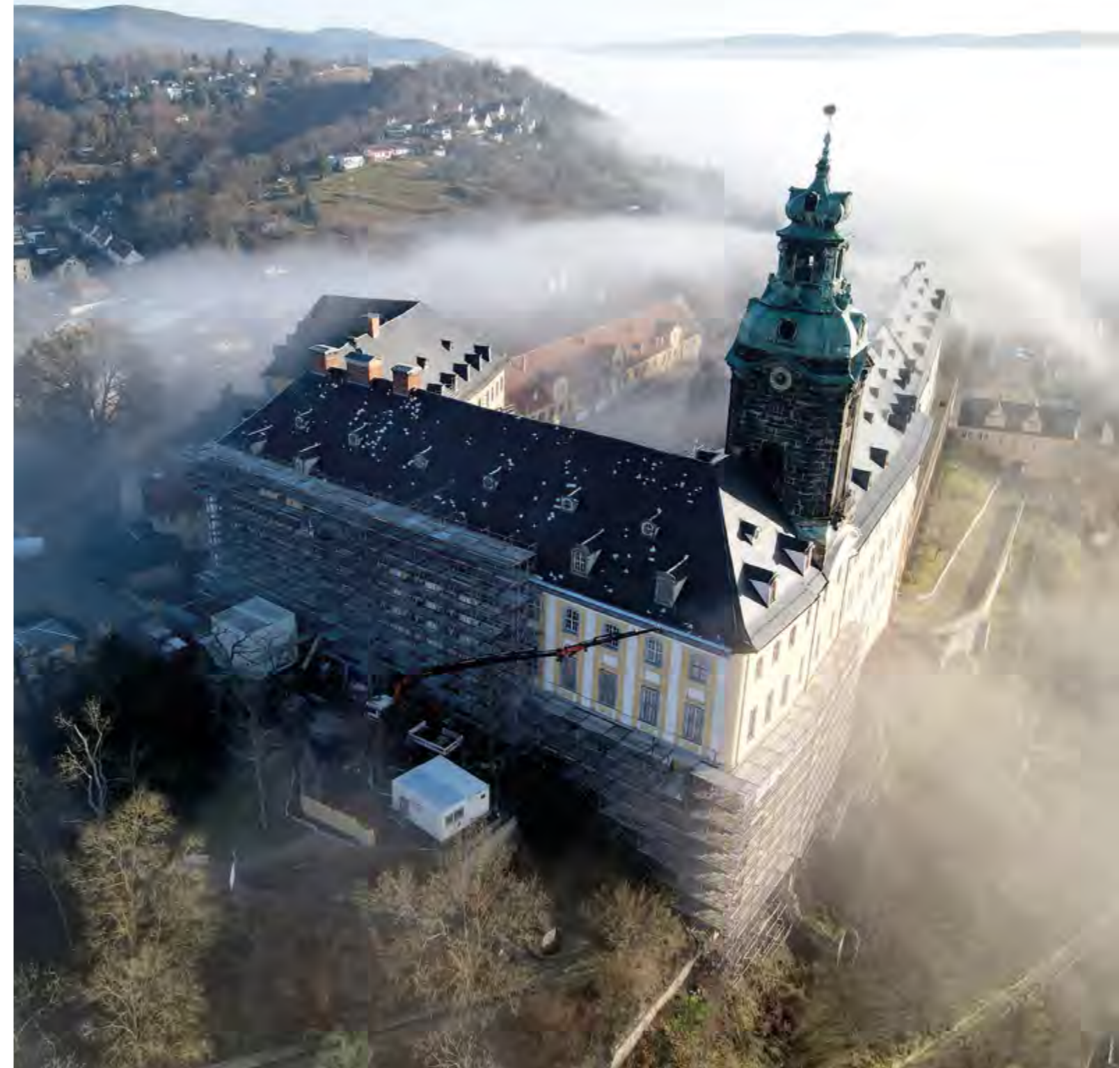
Schloss Heidecksburg während des Gerüstbaus
