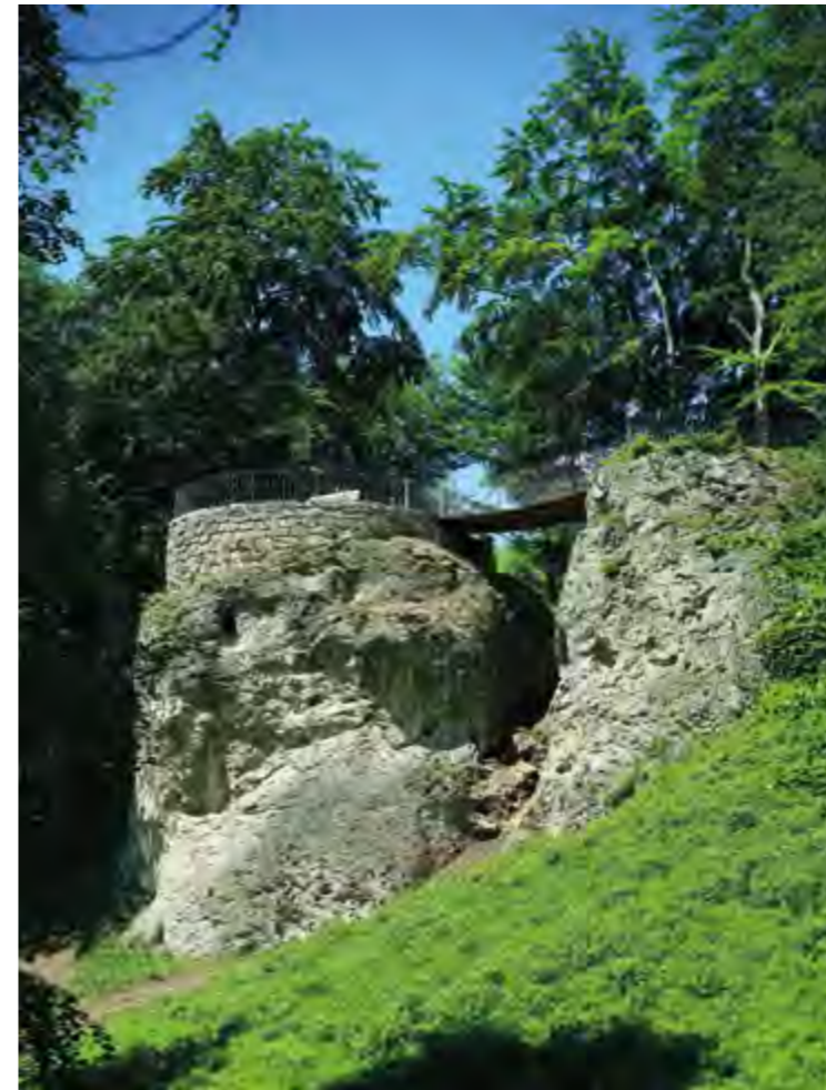
Schlosspark Altenstein, wiederhergestellte Teufelsbrücke
