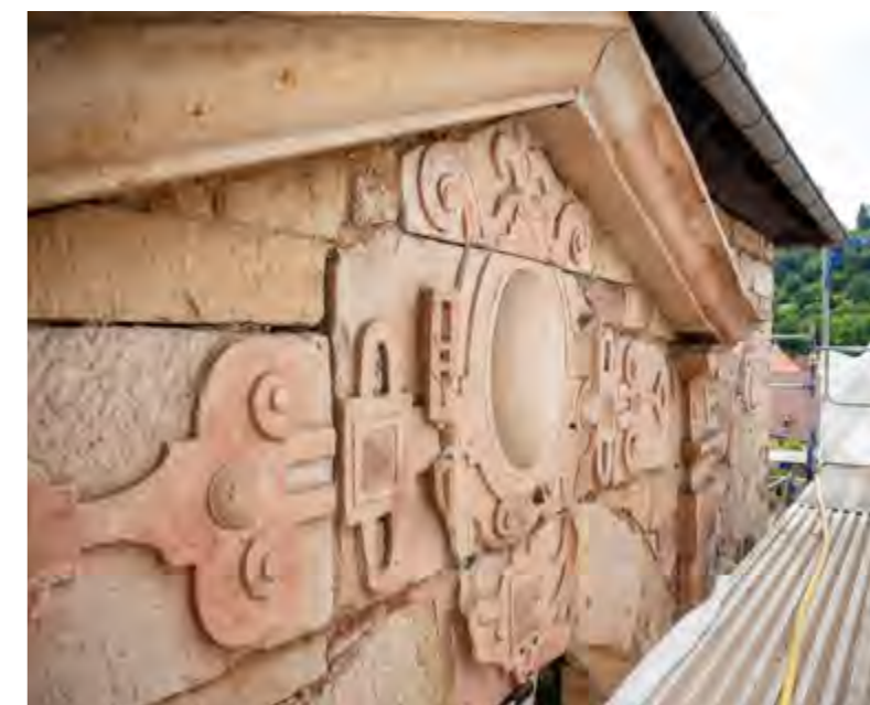
Gereinigtes Ornament am Westportal während der Stützmauersanierung
