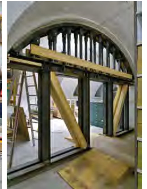
Notsicherungen im Ostturm
