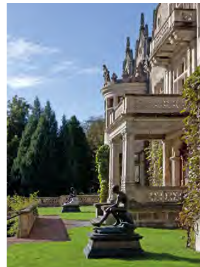
Schloss Altenstein in Bad Liebenstein mit fertiger Außenrestaurierung
