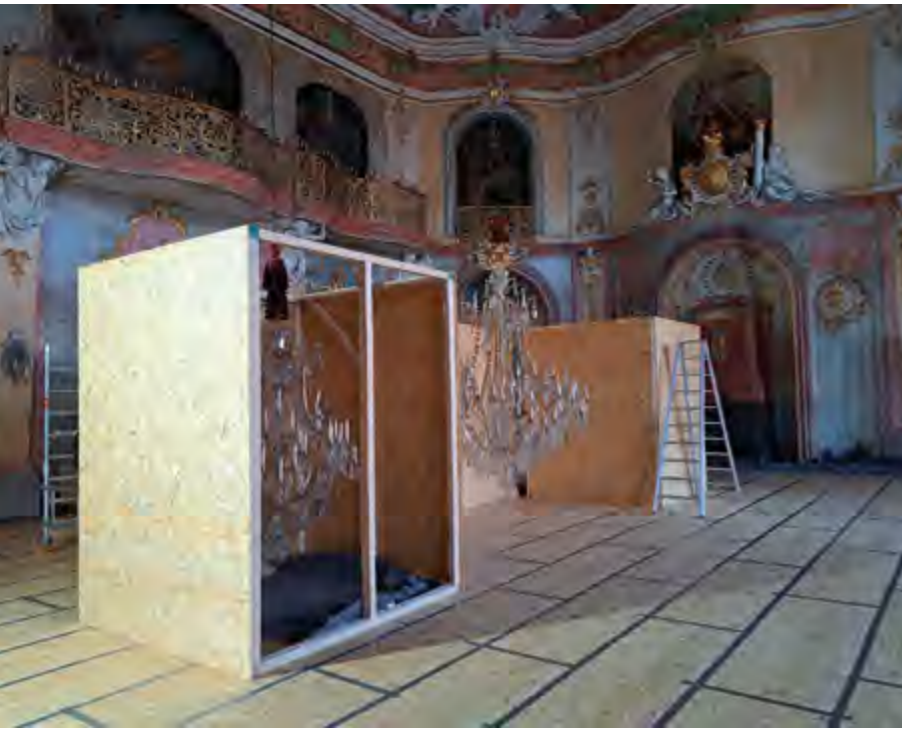
Kronleuchter mit vorbereiteter Einhausung im Festsaal
