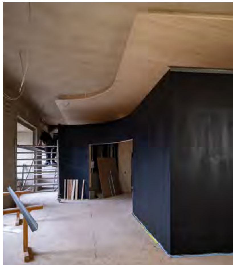
Neuer Servicebereich während der Bauarbeiten
