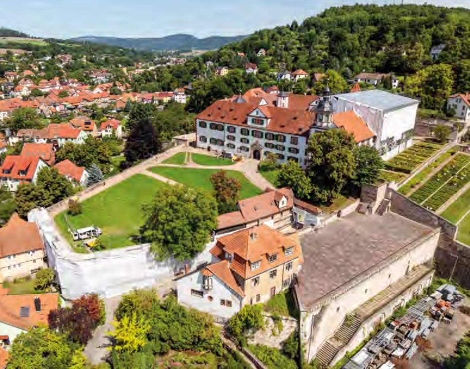
Schloss Wilhelmsburg mit eingerüstetem Südflügel und Stützmauerbaustelle 2025
