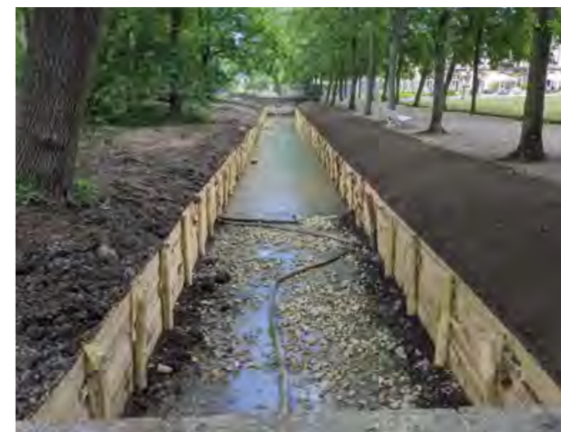
Schlosspark Molsdorf, Ufersanierung in historischer Technik
