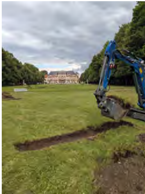
Einem Weg auf der Spur: Schürfe nach einem Wegverlauf im Schlosspark Molsdorf
