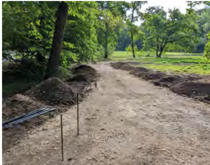
Handwerkliche Tradition: Bau eines Parkwegs im Schlosspark Molsdorf
