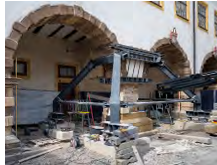
Arkadenpfeiler im Innenhof während der Probesanierung
