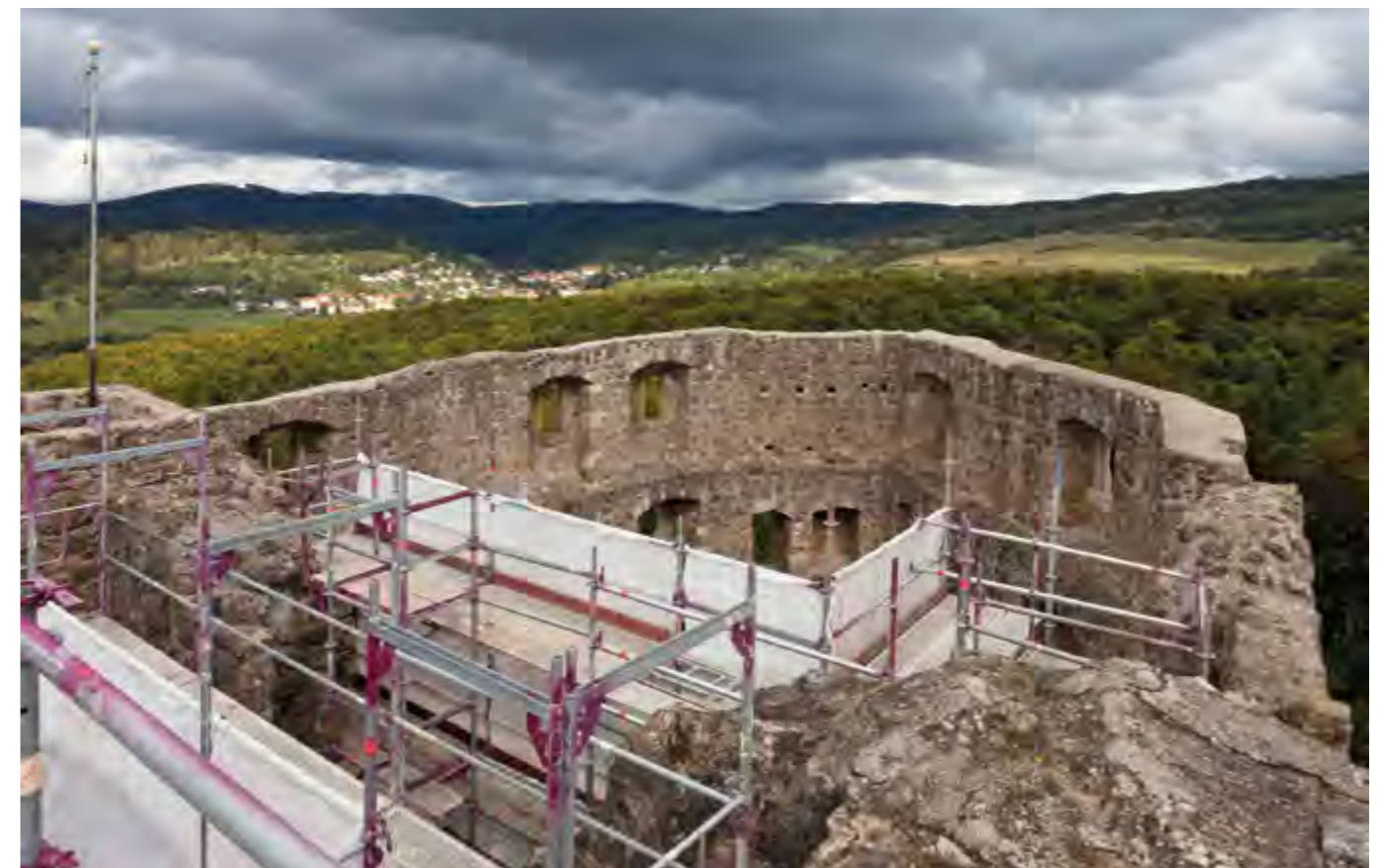
Burgruine Bad Liebenstein mit Baugerüst
