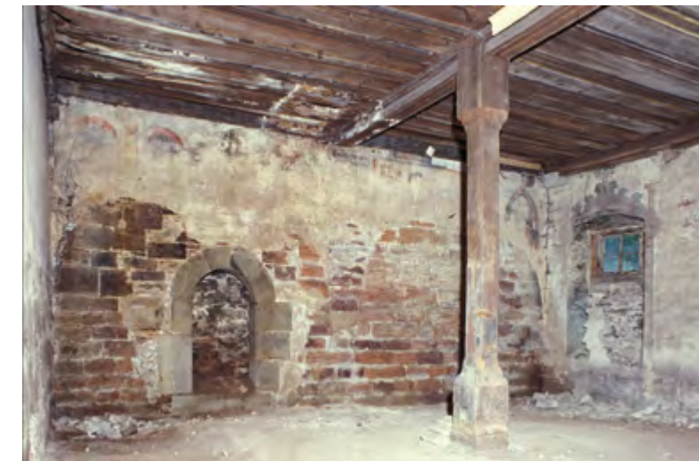
Refektorium mit Gewölbeansätzen, Foto von 1997
