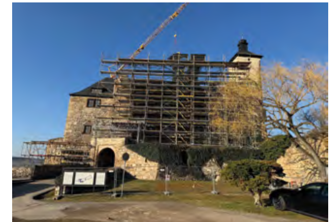
Aufsetzen des Schutzdachs
