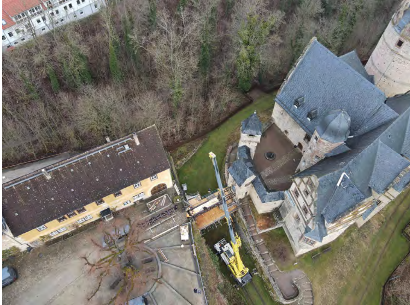
Einbau der neuen Schlossbrücke im Februar 2025
