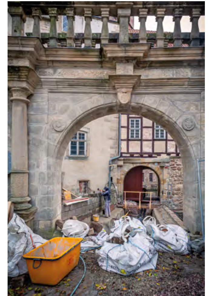
Burgbrücke während der Sanierung 2024
