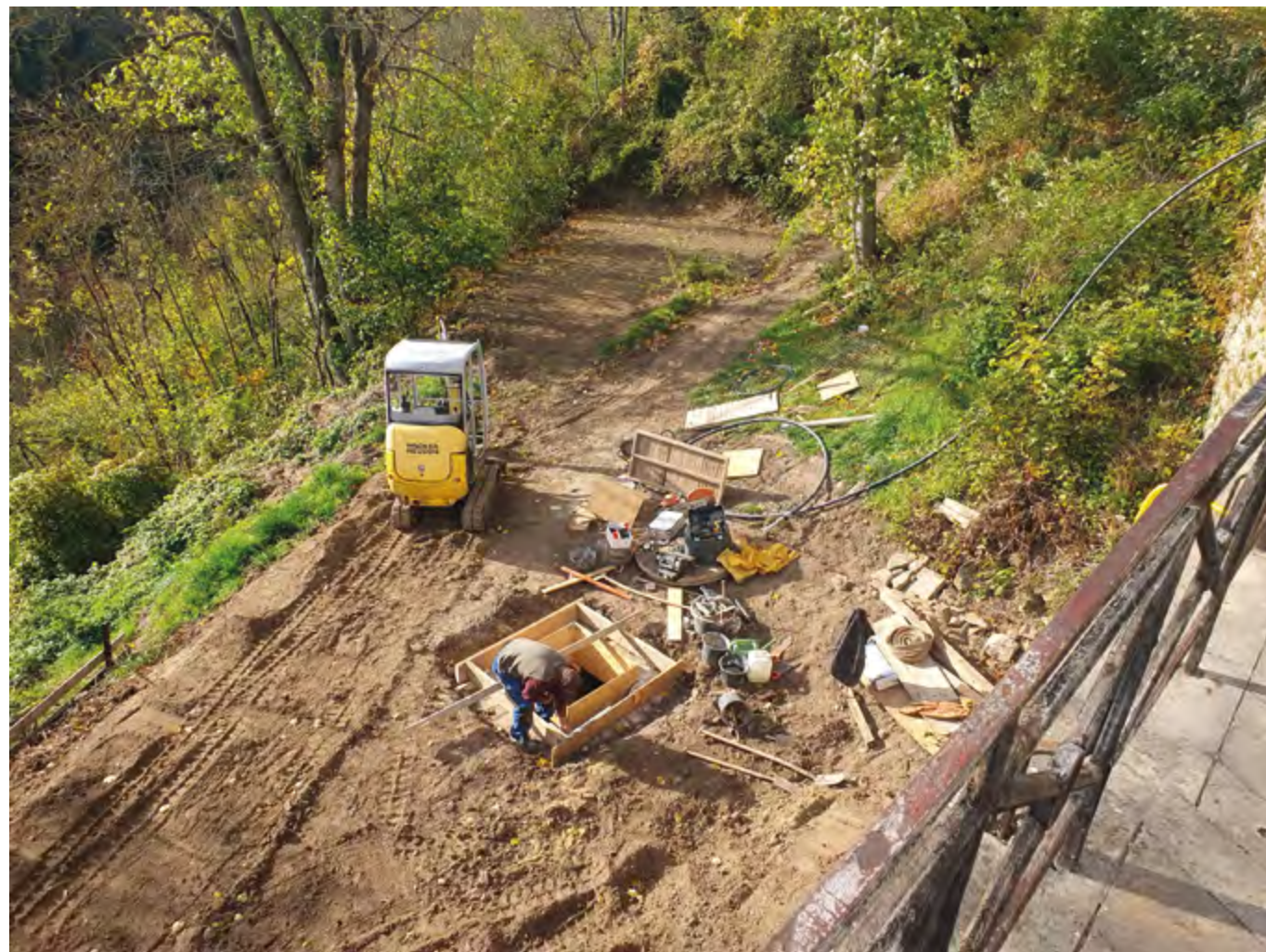
Dornburger Schlossgärten, Umbau einer früheren Klärgrube zur 83-Kubikmeter-Gießwasserzisterne mit angeschlossener Bewässerungsanlage
