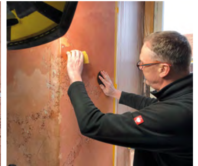
Polierprobe in einer Fensterlaibung
