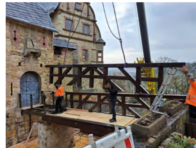
Einheben der neuen Burgbrücke per Kran
