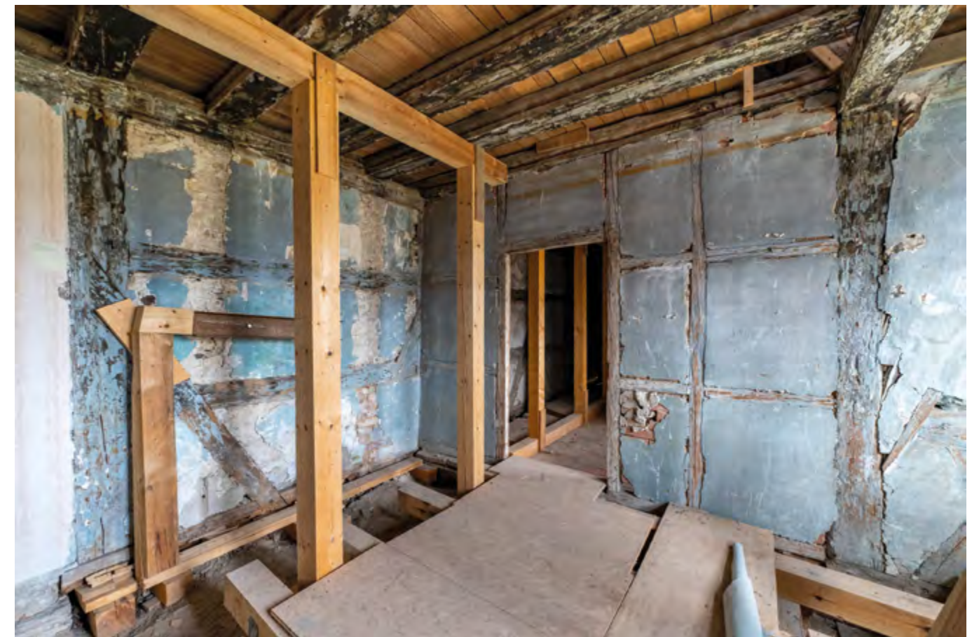
Innenraum mit Sicherungsstützen
