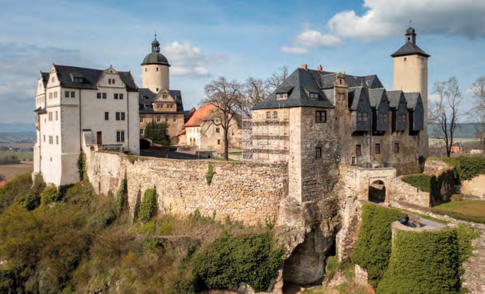
Burg Ranis, Torhaus vor Beginn der Bauarbeiten
