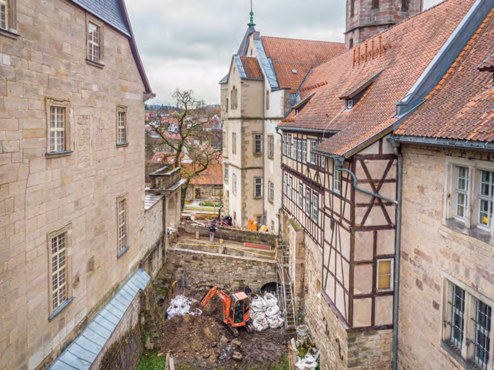
Schloss Bertholdsburg mit Brückenbaustelle
