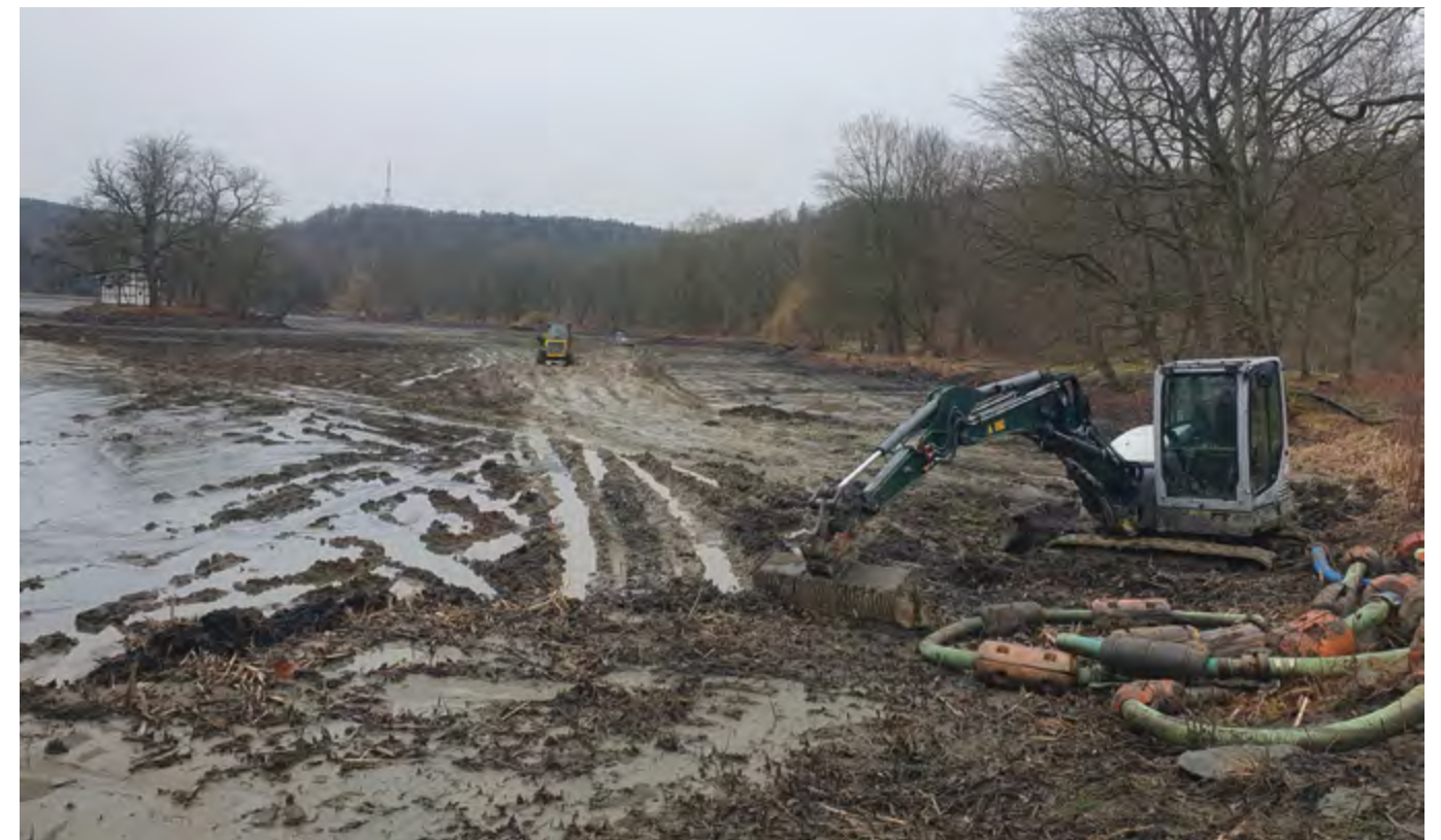
Bagger im Greizer Parksee
