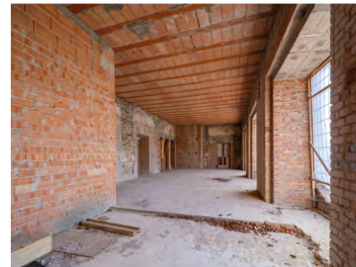
Sanierungsbereich im Erdgeschoss des Hauptgebäudes
