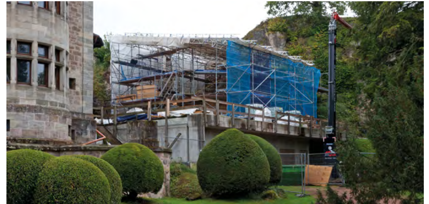
Sanierung des Küchenbaus 2024
