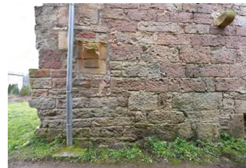
Baufuge an der Außenfassade
