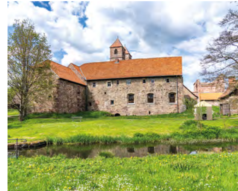
Südliches Klausurgebäude von Süden
