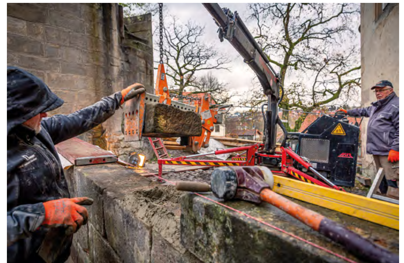
Aufmauern der Brückenwangen
