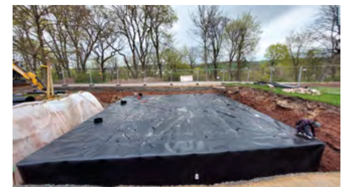
Bau der Zisterne auf Schloss Sondershausen
