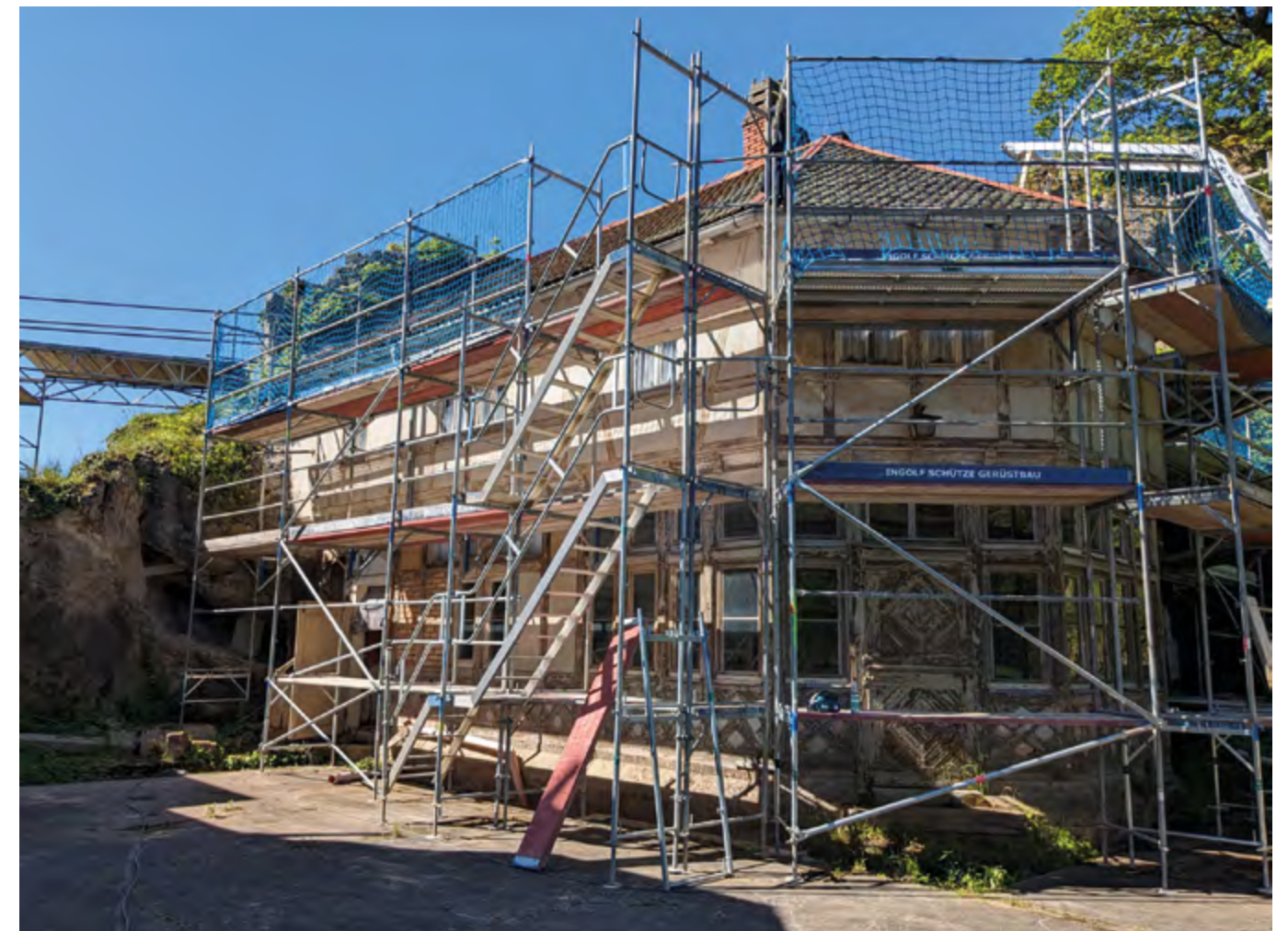
Herzoglicher Küchenbau mit Gerüst für die Sanierung
