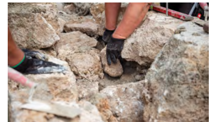
Mauerwerkssanierung im SIP I
