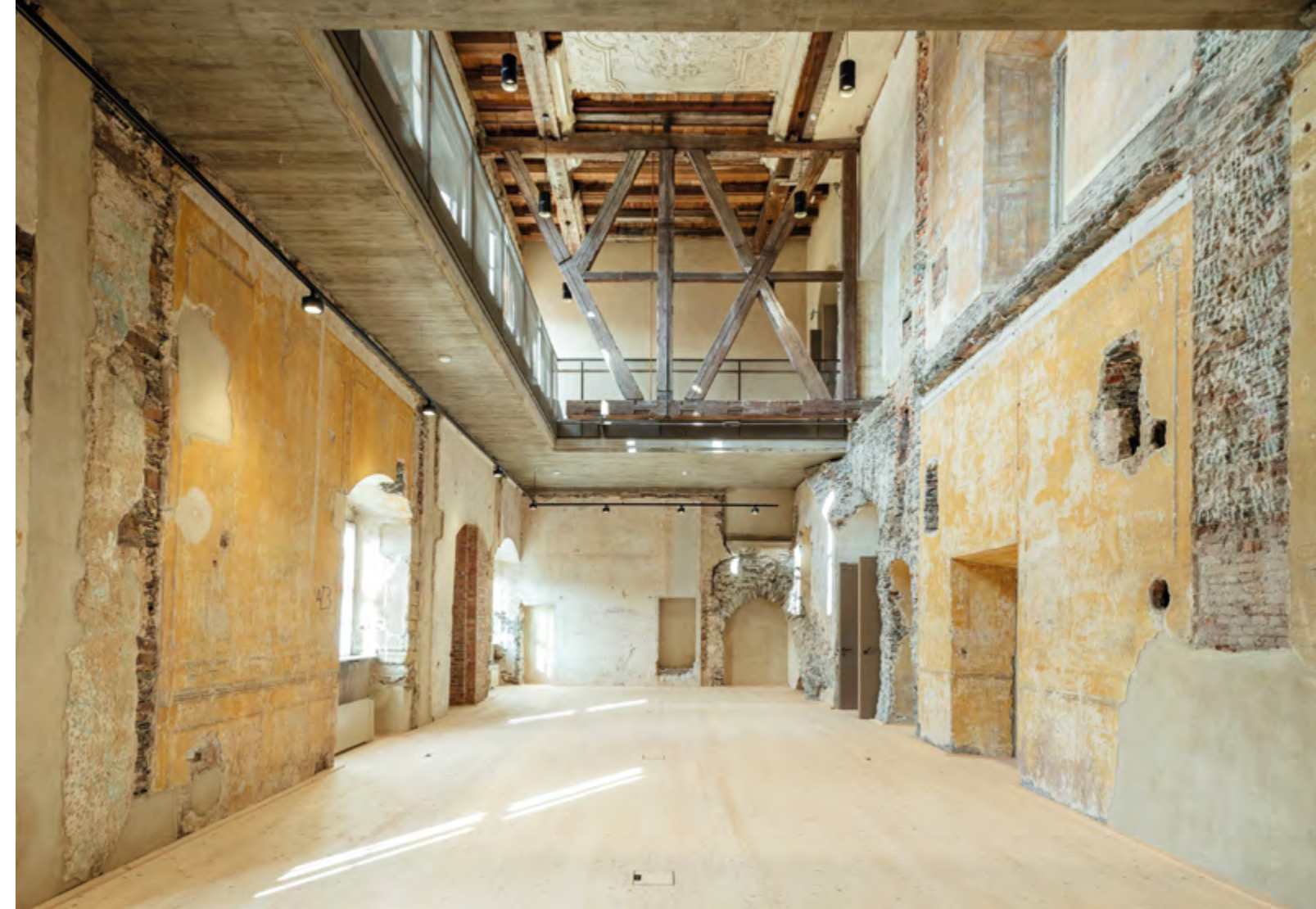
Schloss Schwarzburg, sanierter Emporensaal mit Spuren des Umbaus 1940-42
