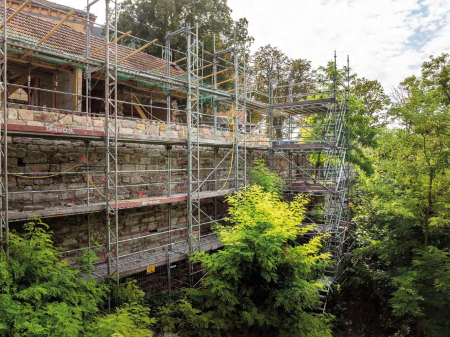
Burg Weißensee, Eingerüsteter Sanierungsbereich an der Ringmauer
