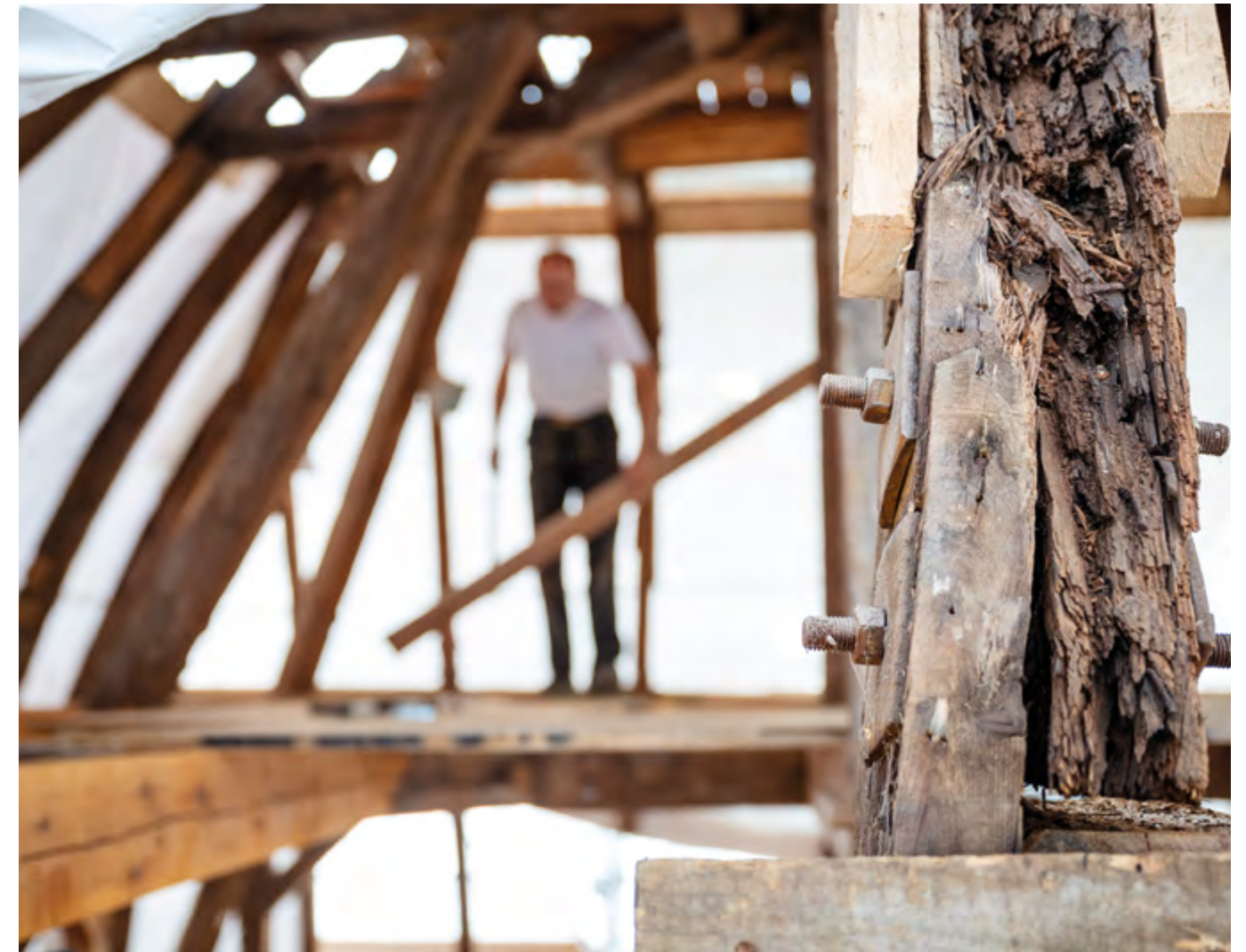
Turmhaubensanierung unter dem Wetterschutzdach
