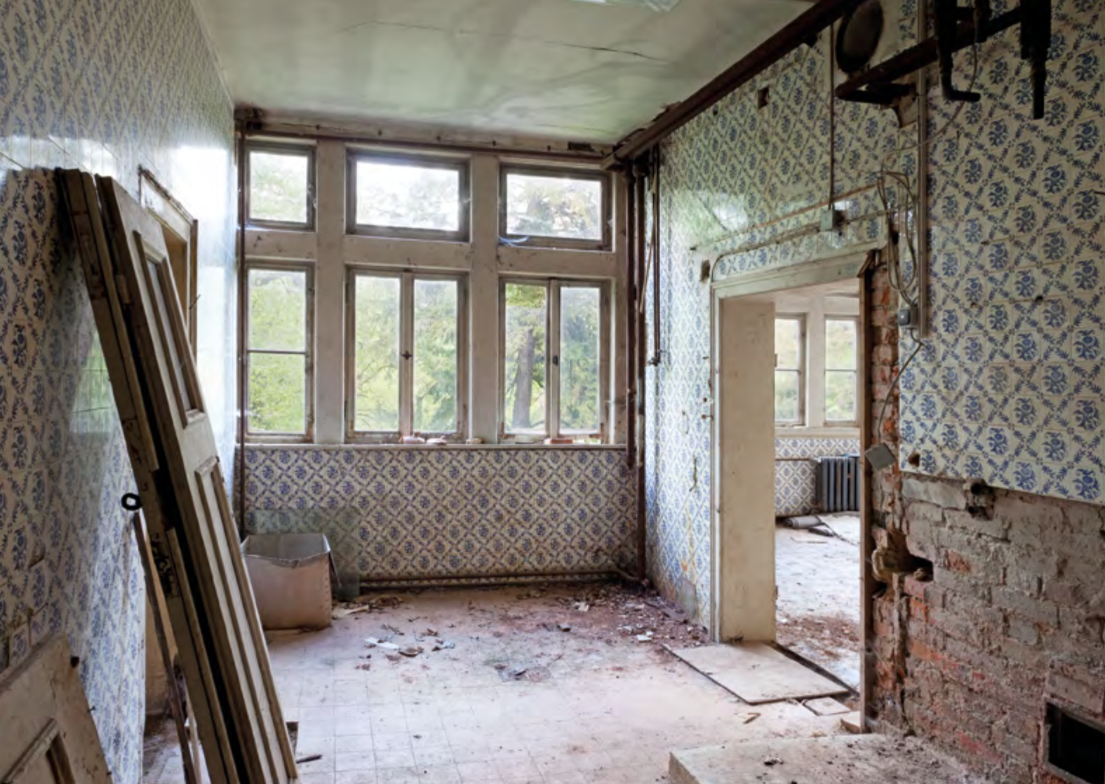
Historischer Küchenbau vor Sanierungsbeginn
