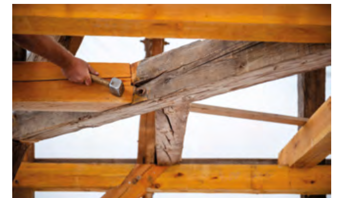
Tragwerkssanierung der historischen Turmhaube
