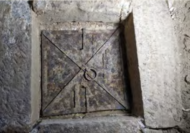
Die Sanierung von Schloss Friedenstein in Gotha ist eine Mammutaufgabe. Im Westflügel kommt bei den Bauarbeiten Interessantes ans Licht ... S. 38
