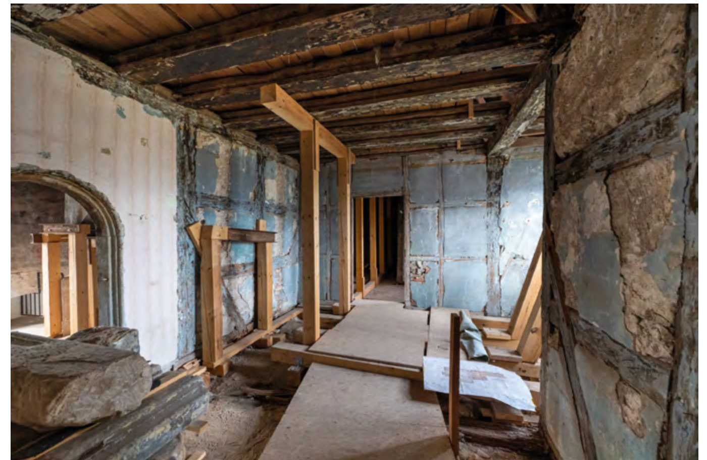
Obergeschoss im Torhaus
