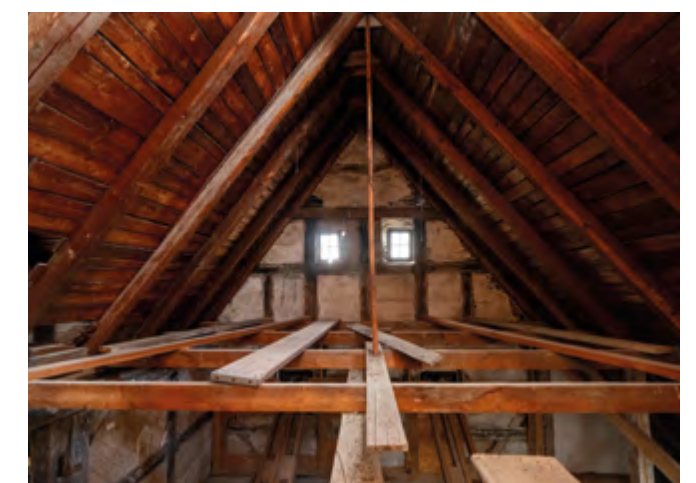
Dachstuhl des Torhauses
