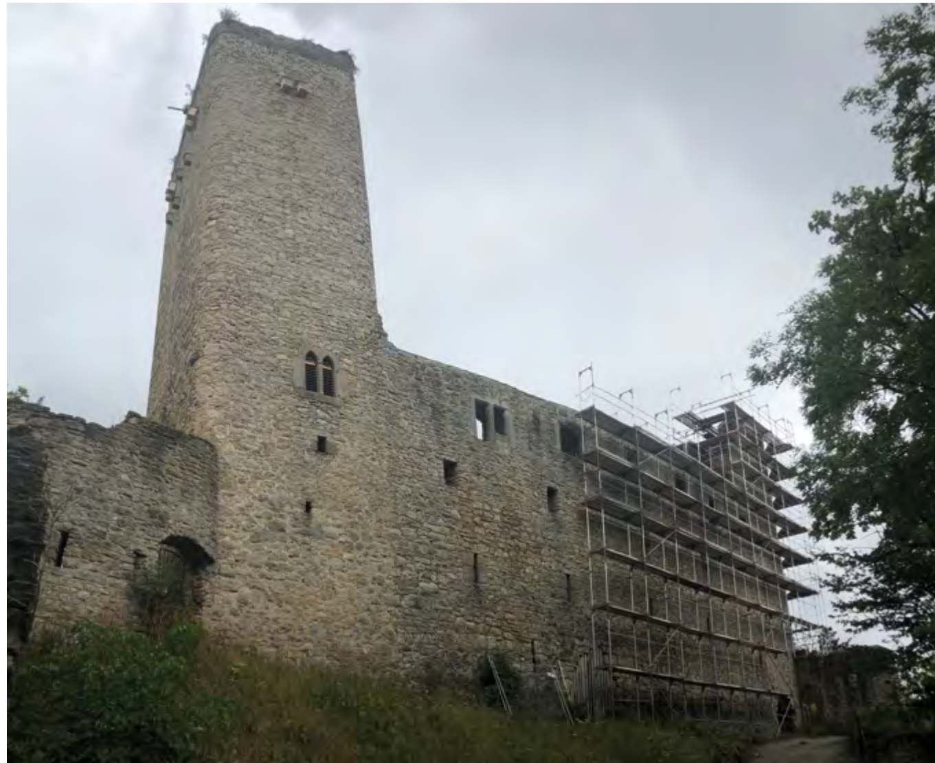
Burgruine Ehrenstein mit Gerüst für die Mauerwerkssanierung
