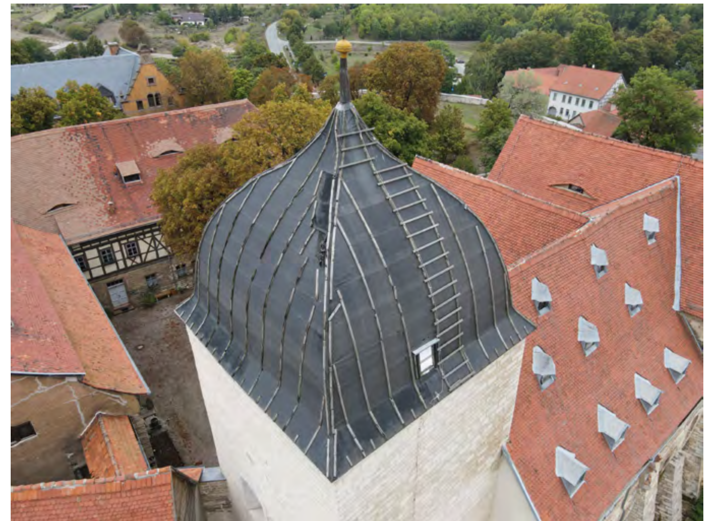
Turmhaube mit Noteindeckung
