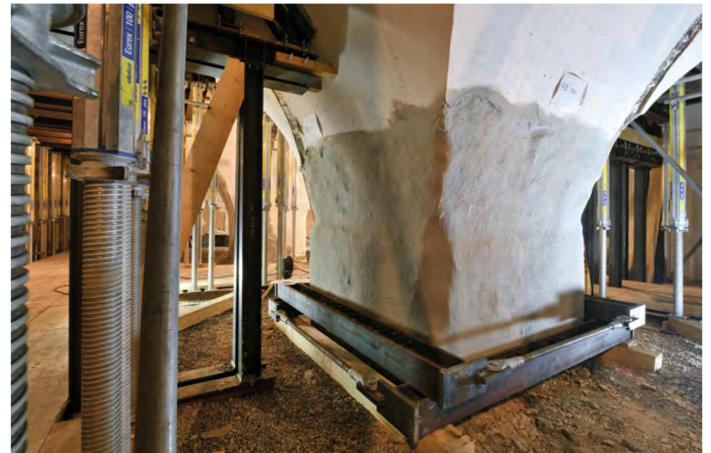
Während der Pfeilersicherung im Keller des Ostturms
