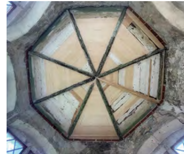
Restaurierte Decke im Obergeschoss
