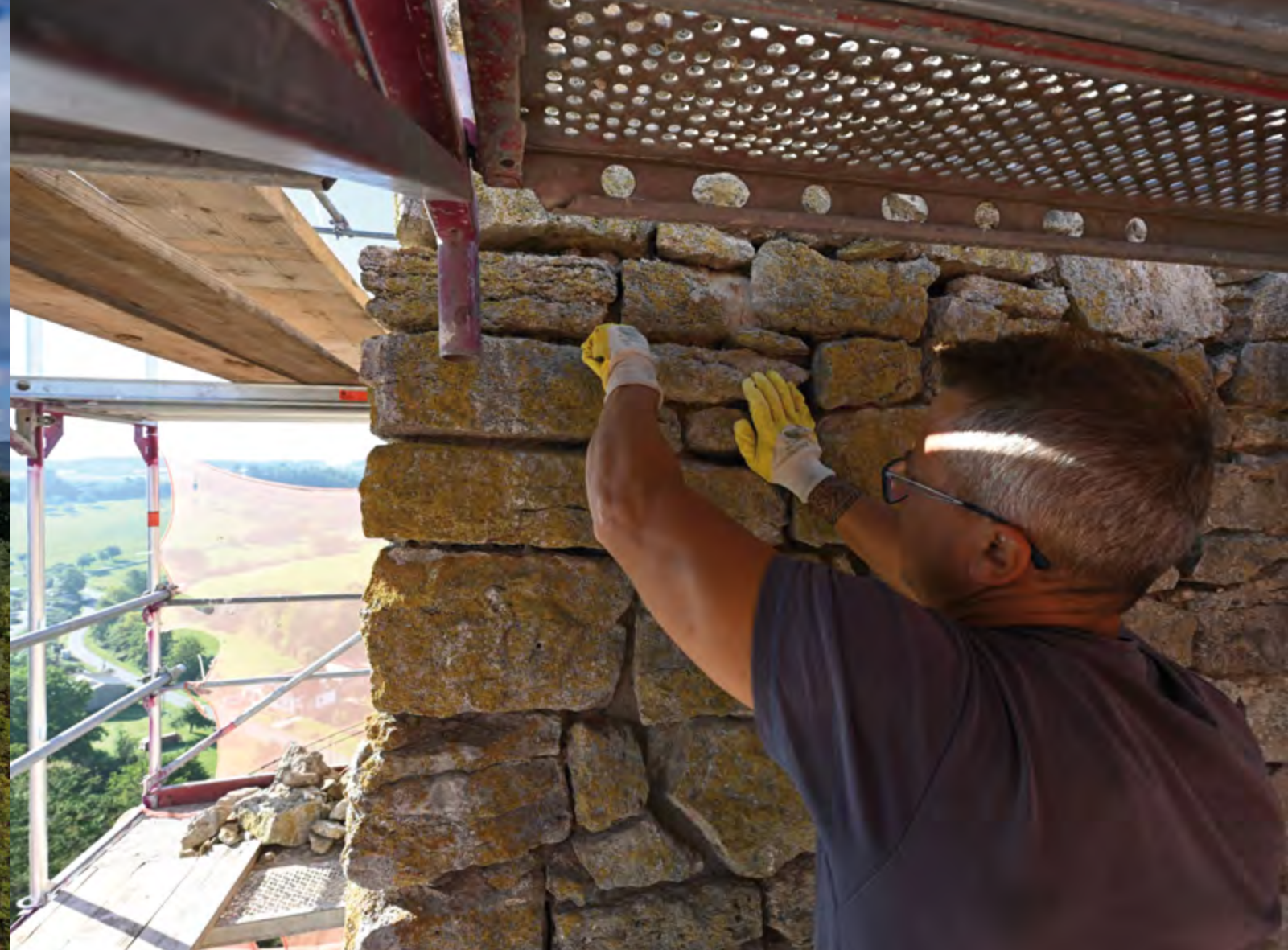
Auf der Burgruine Ehrenstein dreht sich alles ums Mauerwerk
