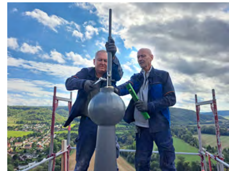
Aufsetzen des Turmknopfs zum Abschluss der Haubensanierung
