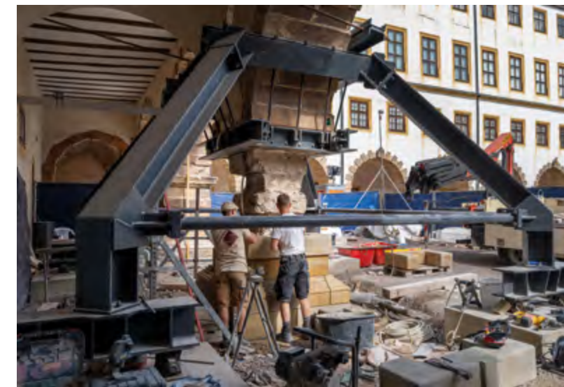
Stützkonstruktion zum Abfangen der Lasten
