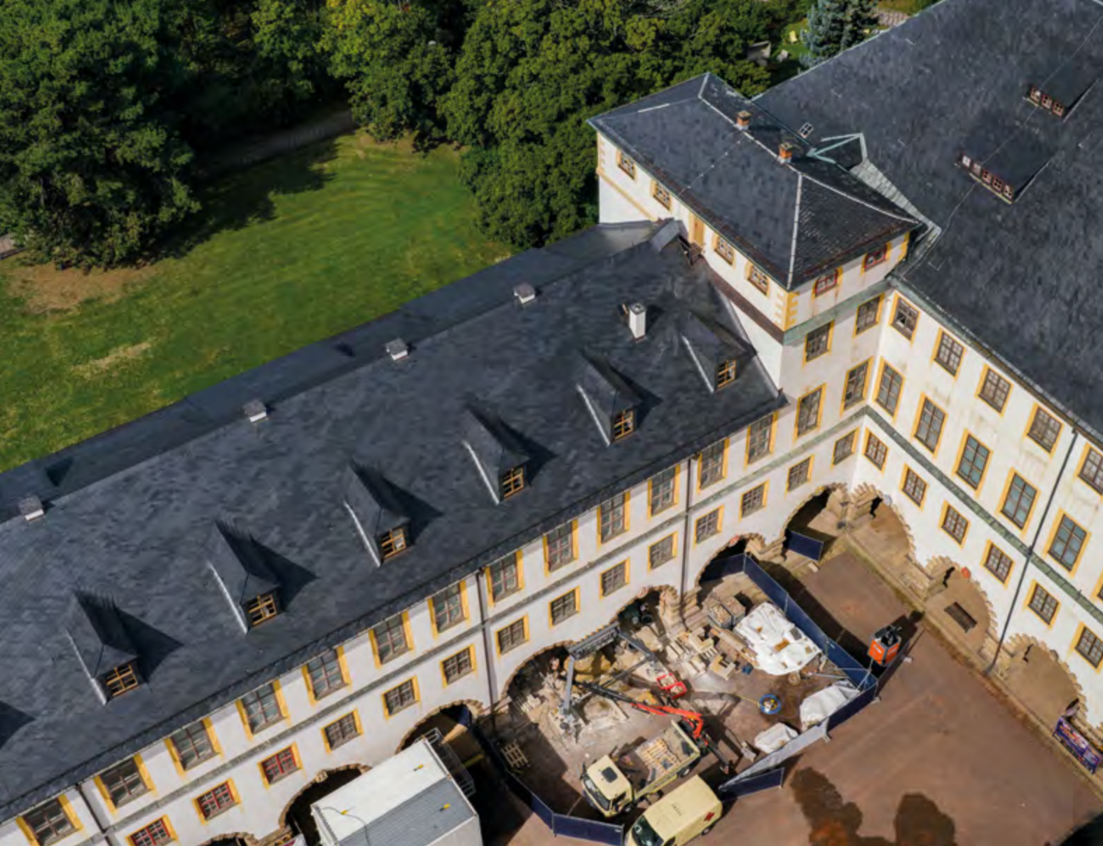
Schloss Friedenstein Gotha, Baustelle zur Pfeilersanierung im Schlosshof
