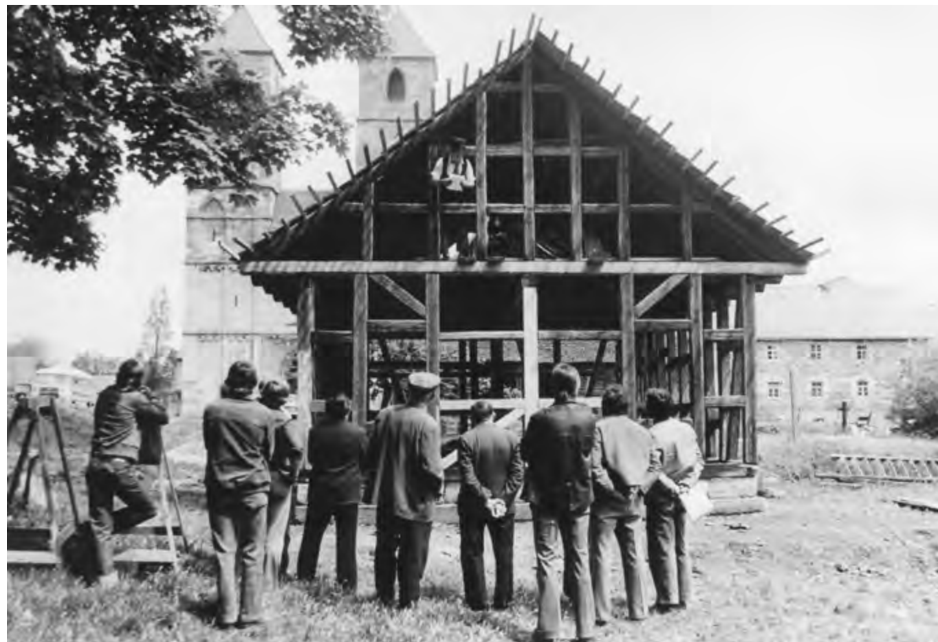
Richtfest der translozierten Schmiede aus Leutersdorf am 26. Juni 1981
