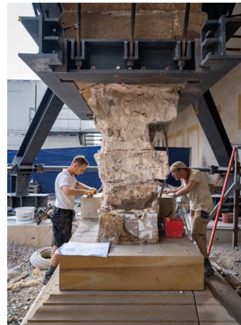
Anspruchsvolle Handwerksarbeit beim Aufbau der äußeren Mauerschale
