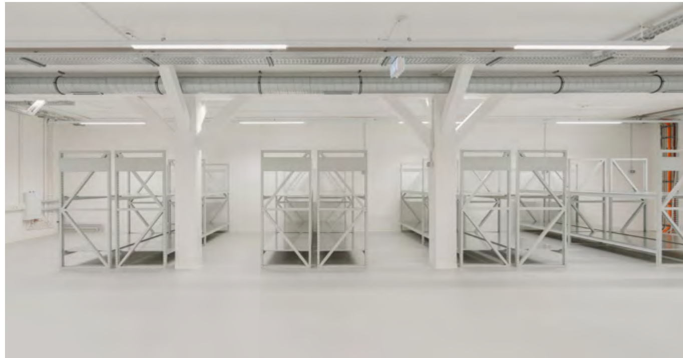
Depoträume im Sammlungszentrum Henneberger Land
