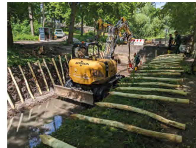
Einbau der Uferbefestigung
