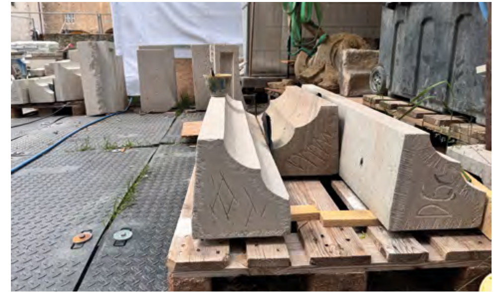
Bauhütte mit neuen Schmuckelementen
