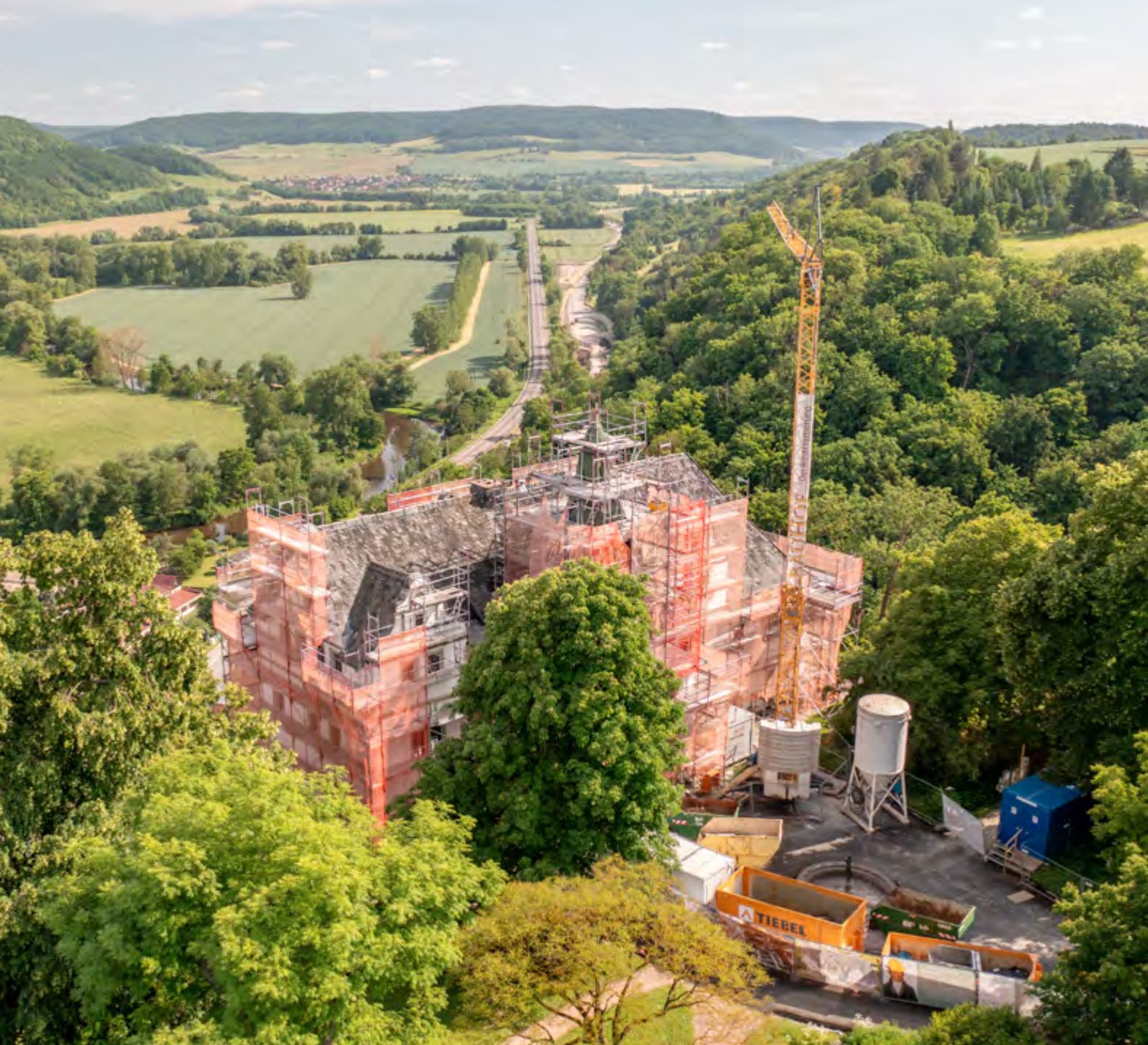
Renaissanceschloss Dornburg mit Gerüst
