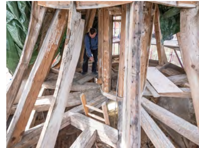
Freigelegte Turmhaubenkonstruktion während der Sanierung
