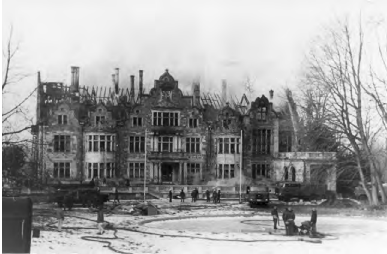
1982 brannte Schloss Altenstein im Inneren aus, der Brand ist bis heute im Gedächtnis geblieben. Im Rahmen des SIP I wird die Innensanierung des Schlosses abgeschlossen und damit wieder eine Nutzung ermöglicht.
