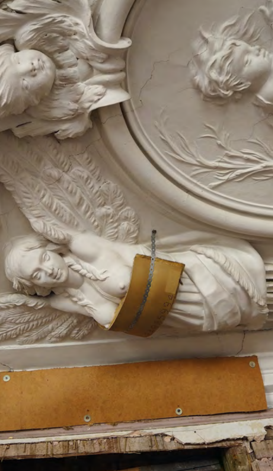
Notabgestützter Stuck aus dem 17. Jahrhundert in den Alten Flügeln von Schloss Sondershausen.
