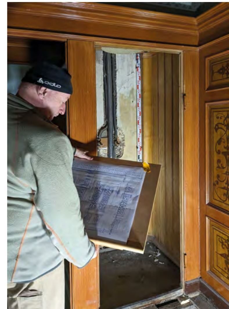
Restaurator Stephan Keilwerth bei Rückbauarbeiten im Westflügel
