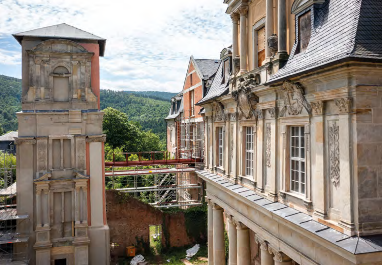
Schloss Schwarzburg, Stahlbrücke zwischen Schlosskirchturm und Schloss als zweiter Rettungsweg
