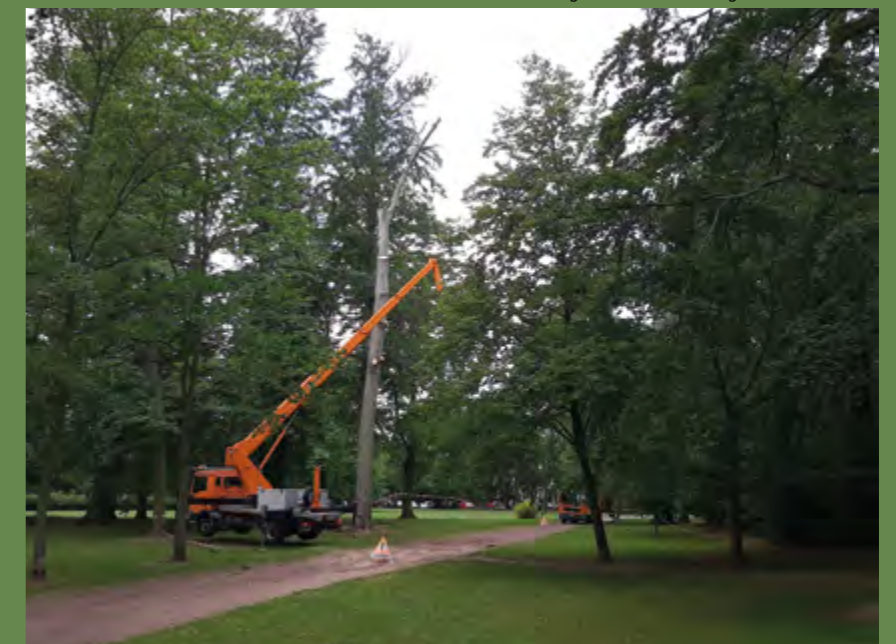
Sicherungsarbeiten im Herzoglichen Park Gotha
