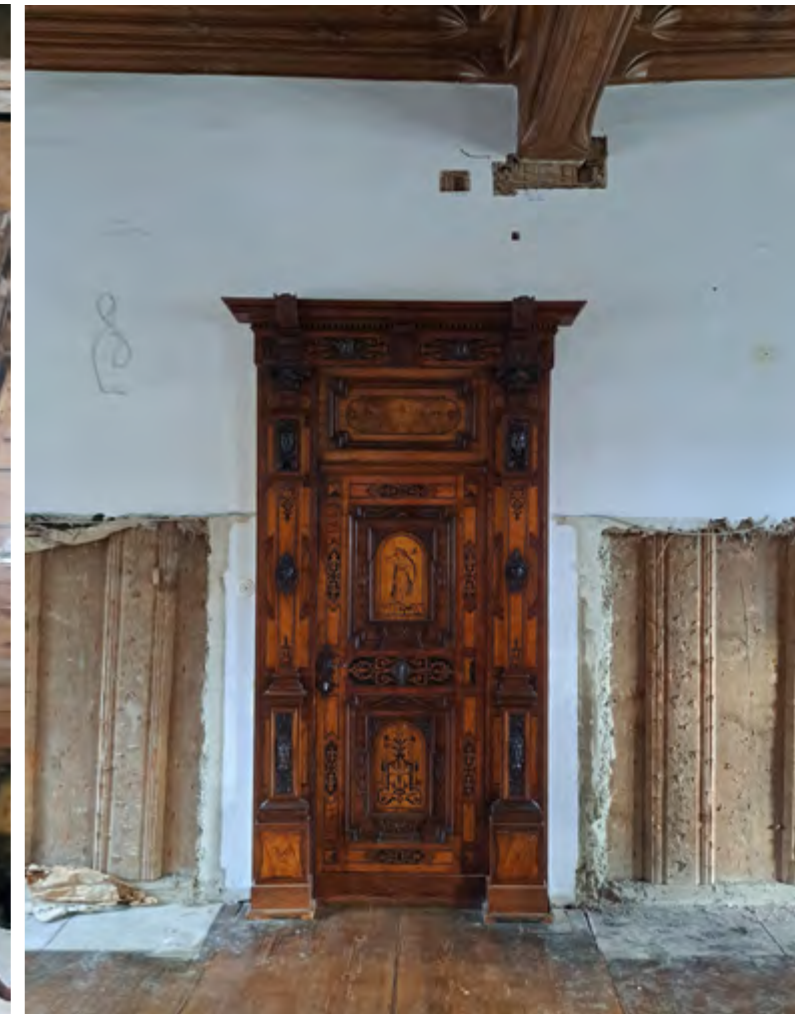
Freilegung der Konstruktion im früheren Carl-August-Zimmer
