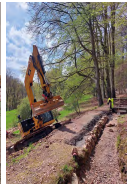
Wiederherstellungsarbeiten im Schlosspark Altenstein
