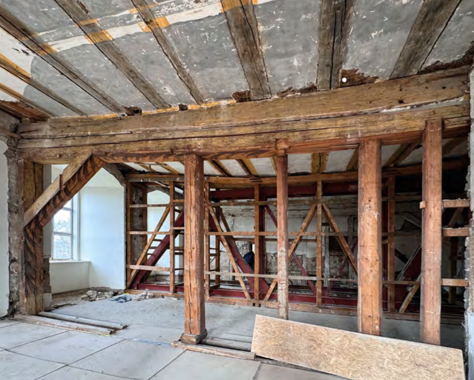
Schloss Friedenstein Gotha, freigelegte Konstruktion im Westturm
