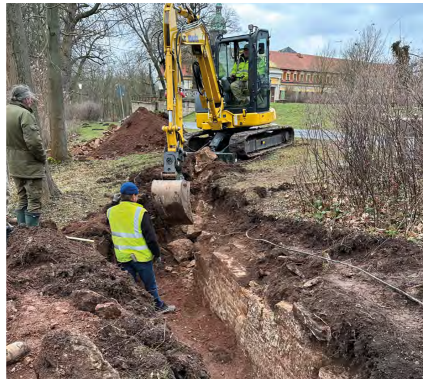
Vorbereitung einer neuen Löschwasserezisterne auf Schloss Sondershausen
