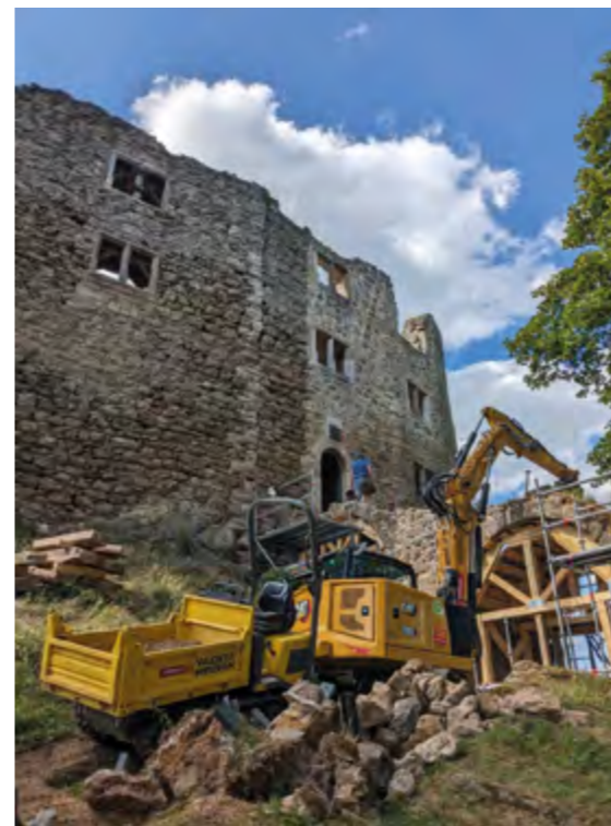
Baustelle an der Burgruine Bad Liebenstein
