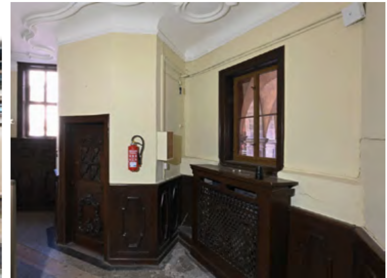
Aufzug im Treppenhaus des Südflügels
