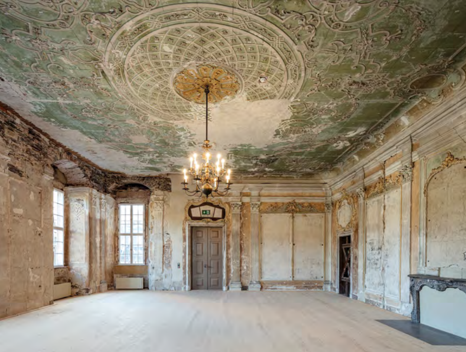
Brandschutztür im 2021 eröffneten Denkort der Demokratie im Hauptgebäude von Schloss Schwarzburg
