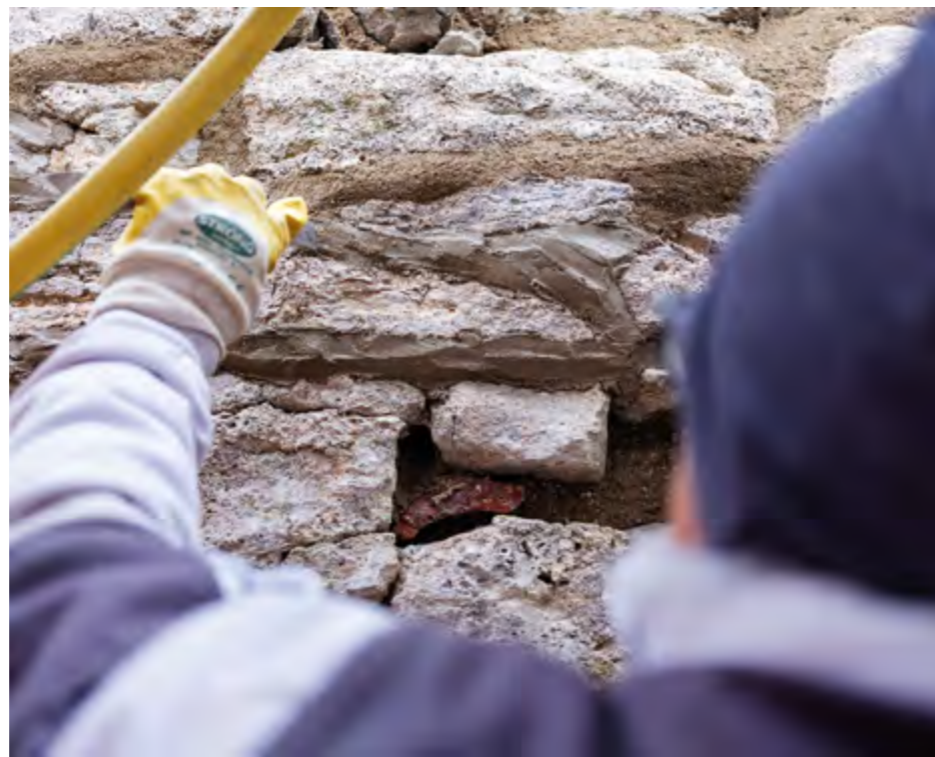
Mauerwerksanierung in Handarbeit
