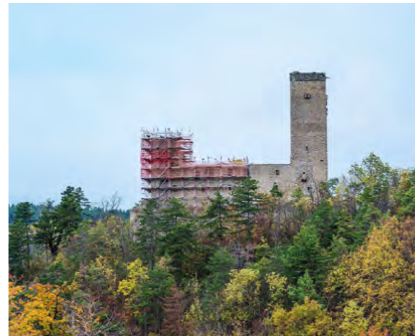
Bauarbeiten auf der Burgruine Ehrenstein
