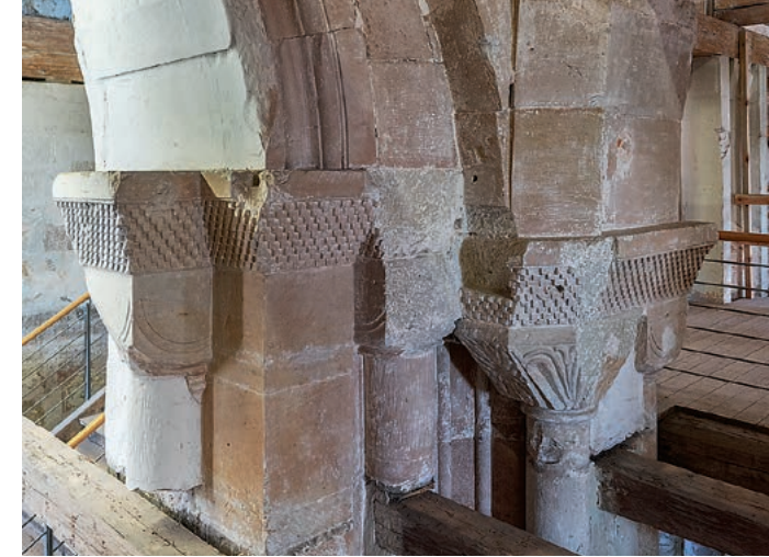
Kapitellzone eines Pfeilers
