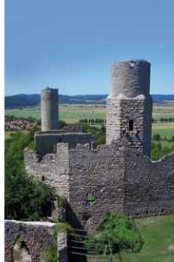
Doppelburanlage von Osten
