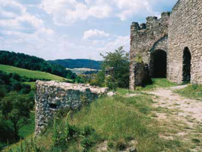
Ostburg, Streichwehr und Torhaus
