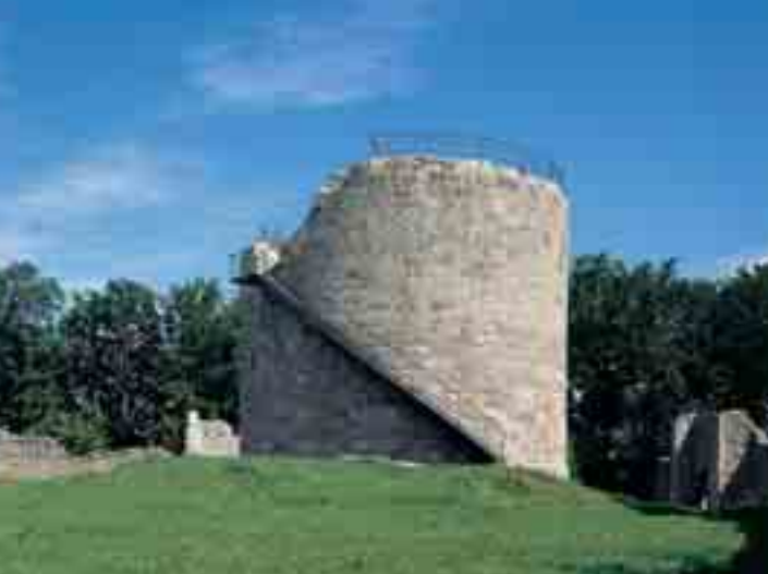
Bergfried, Ansicht von Süden
